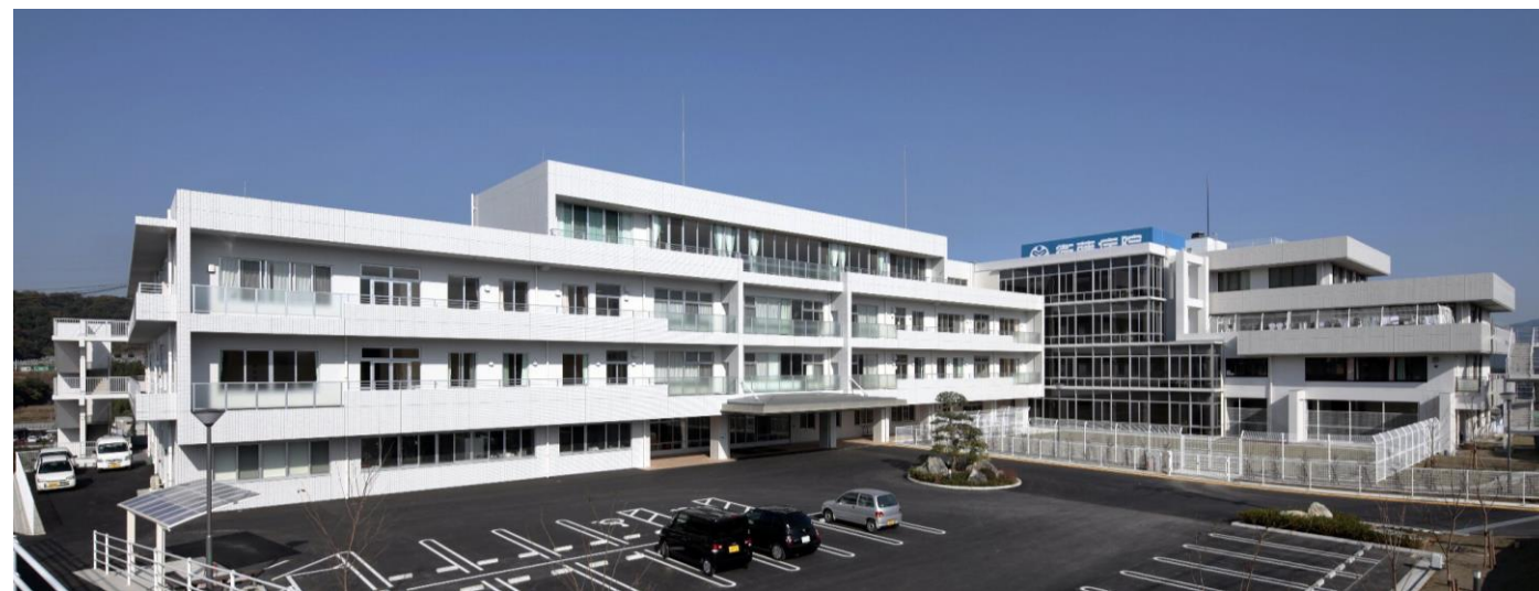
南側外観（庇としてのバルコニー設置）
