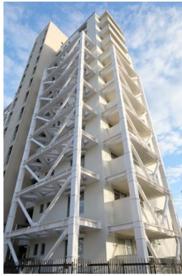
図 制震ブレース取付状況
