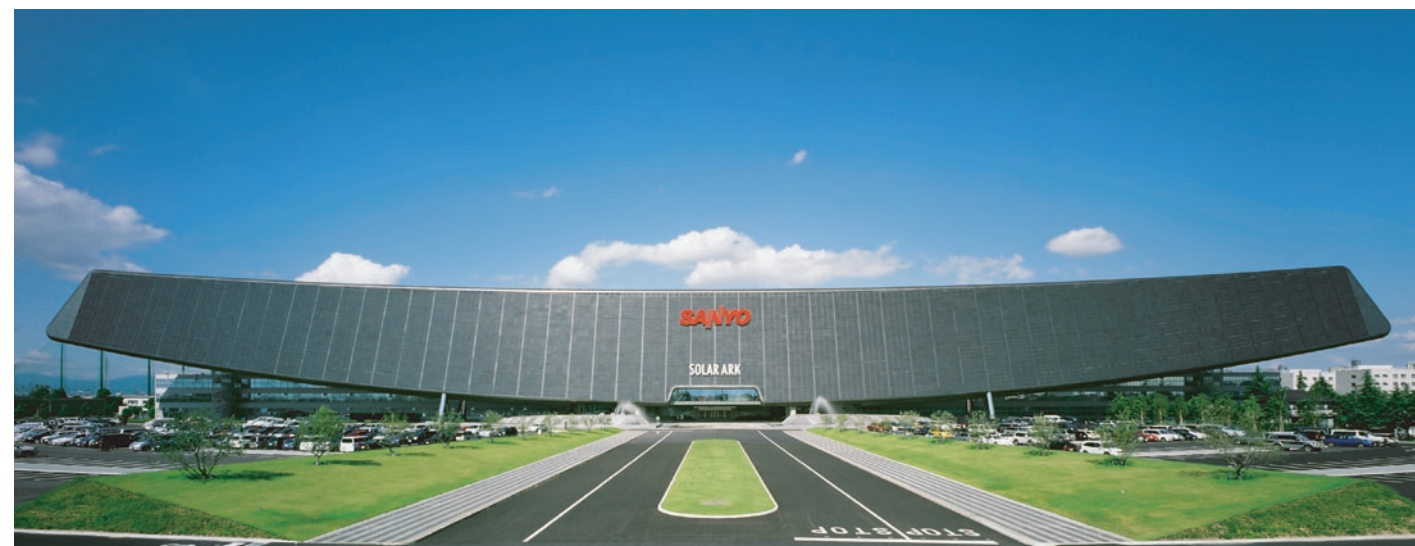
南側全景 幅315m、高さ37mの巨大モニュメントが4本の柱で浮いている
