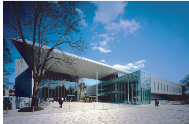
銀杏並木から中庭へ導くエントランスゲート
