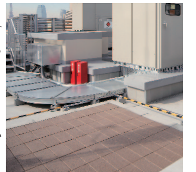
屋上の保水性舗装材
