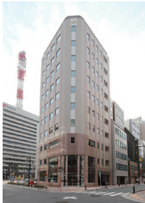
新銀座店舗 北側道路路面ファサード
