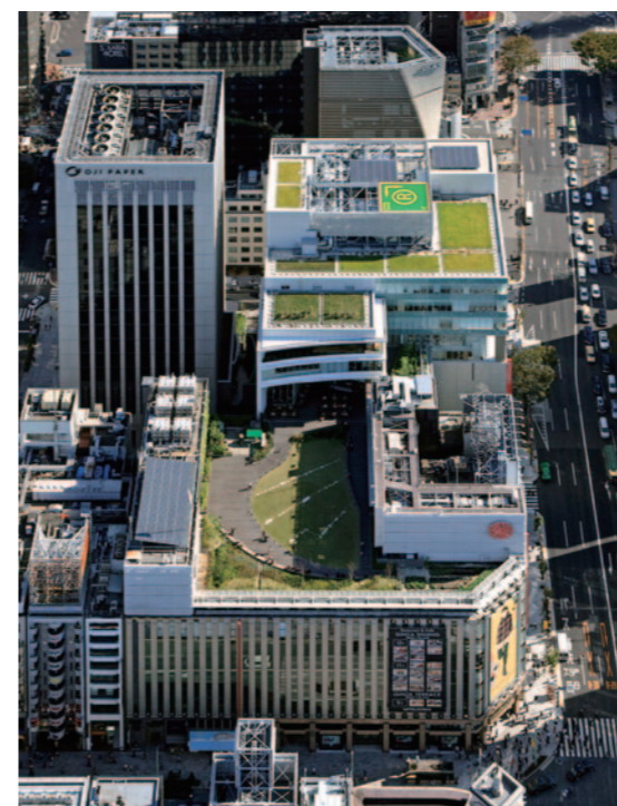
屋上緑化・太陽光パネル
