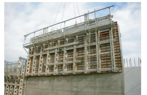
足場付鋼製システム型枠脱型状況
