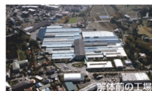
解体前の工場
