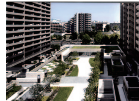
南駐車場棟（屋上庭園）
