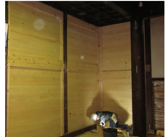
「スーパー板壁」施工状況
