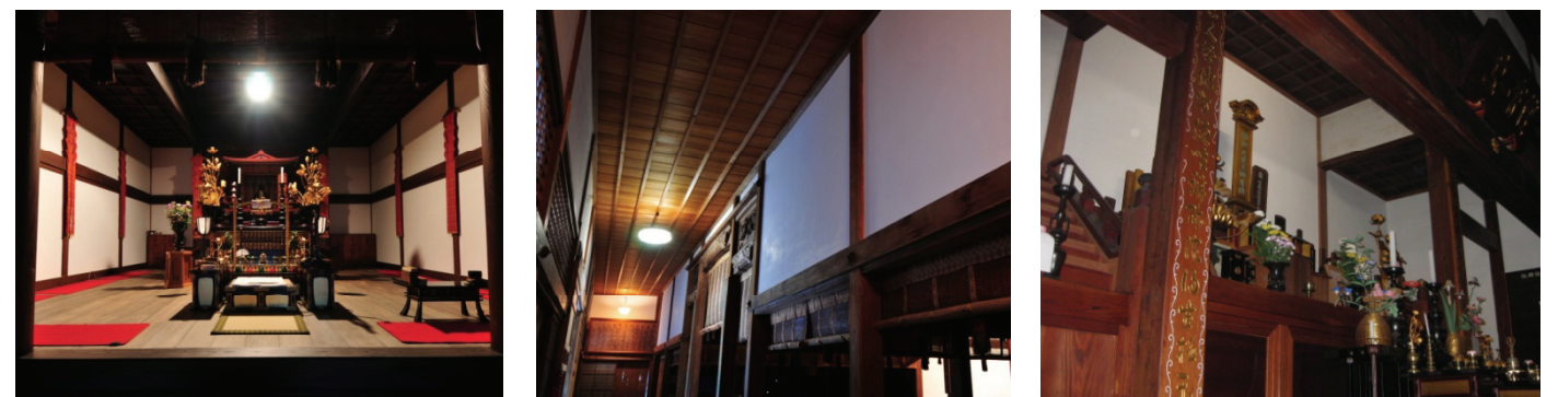
耐震壁補強部【漆喰塗仕上】の竣工状況（左：内陣 中：外陣廊下 右：位牌堂）
