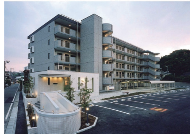
外観写真（東側より）
