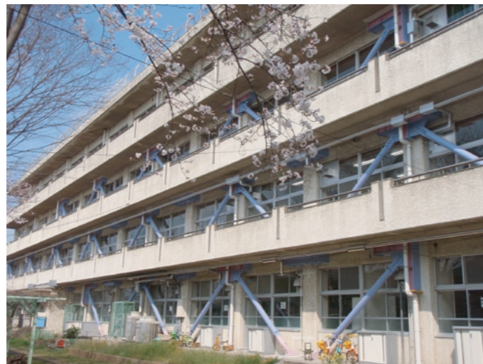
補強建物全景
