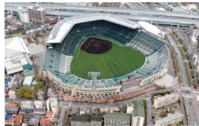
2010年竣工後（太陽光発電設備搭載）
