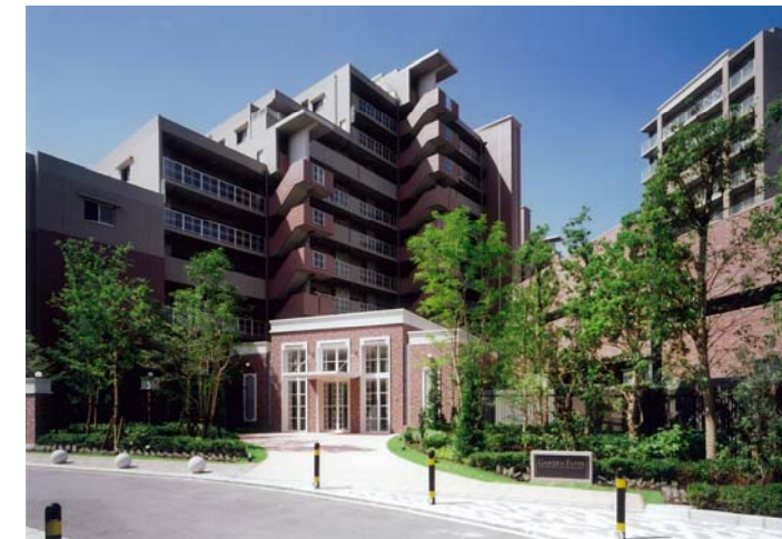
建替工事による分譲マンション外観
