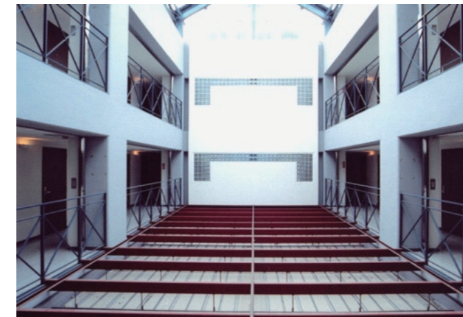
吹抜け（改修前）
