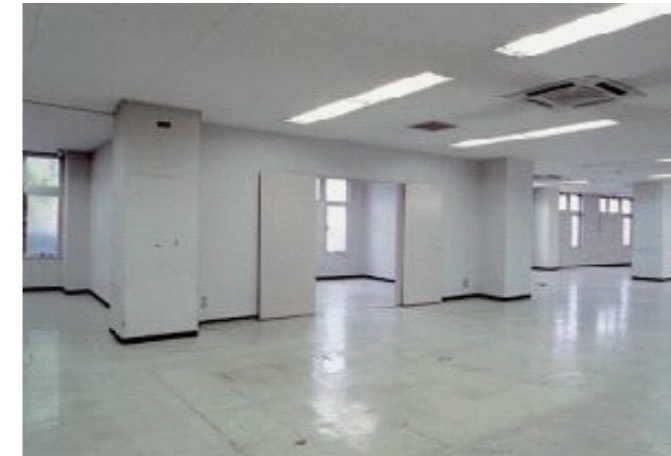
エントランスロビー（改修前）
