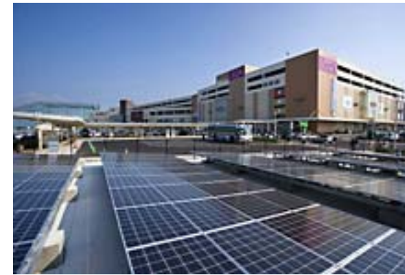
太陽光発電パネル（地上部・バス停屋根）
