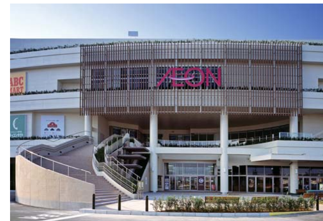
木製ルーバー（再生材利用）
