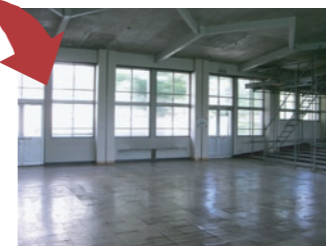
スケルトン化：解体・撤去
