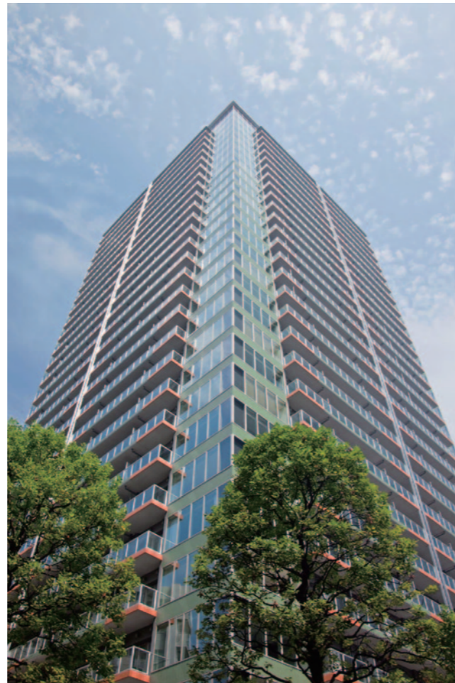
外観写真（南面より）
