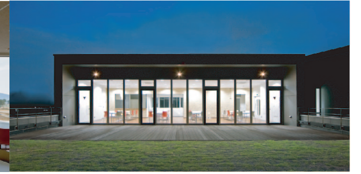
屋上緑化とウッドデッキ
