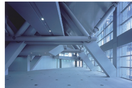
スーパーメガフレームと曲げダンパー
