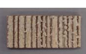
上：旧校舎外壁タイル
