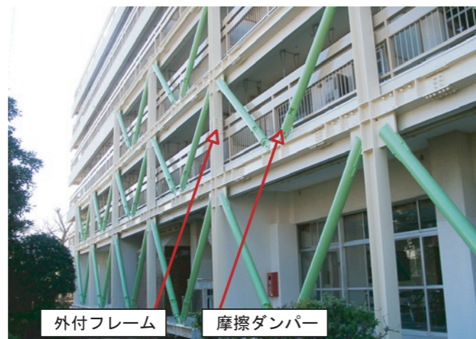
制震ブレース取付状況
