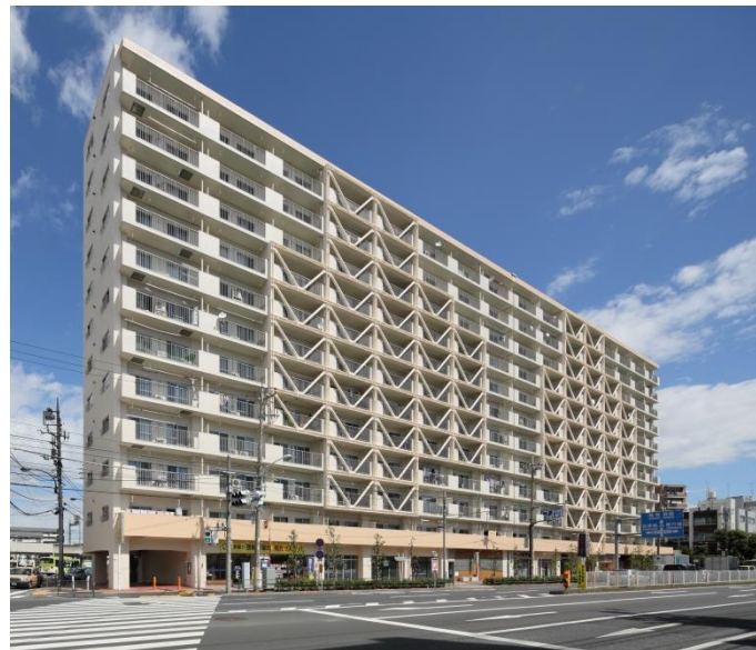
写真 建物外観
