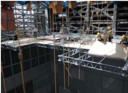
吹抜部作業床
