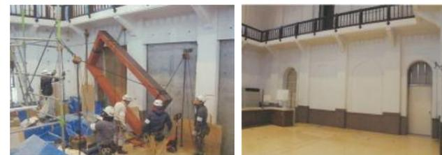
内壁開口部補強 既設開口部をRC壁で塞ぎ、鉄骨4方枠で補強し、飾枠を取付け仕上げています。
