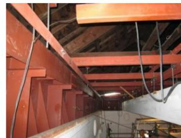
屋根及び煉瓦壁 補強完了
