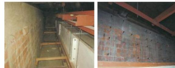
屋根小屋及び煉瓦壁施工前 補強鉄骨取付部アンカー打ち
