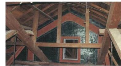
小屋裏補強完了(鉄骨+炭素繊維張り)
