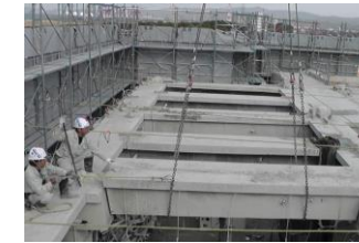
梁切断後吊上げ状況
