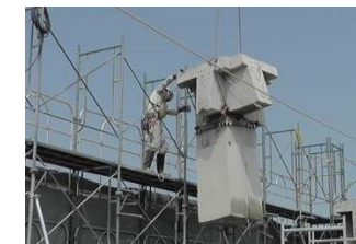
柱切断後吊上げ状況
