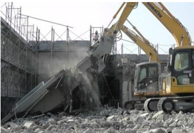
重機解体外壁倒し状況
