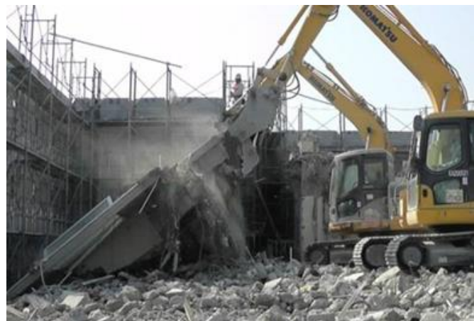
重機解体外壁倒し状況
