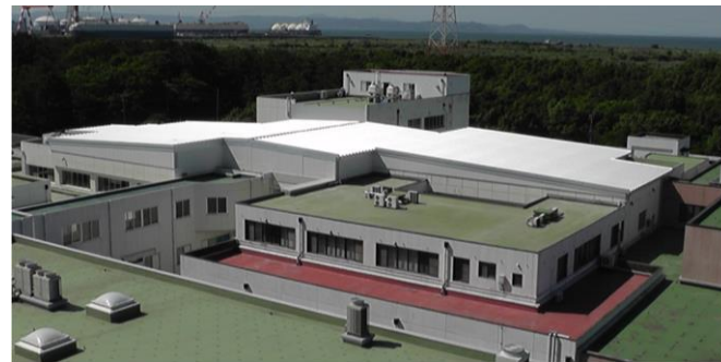
建物外観(上：着工前、下：完成後)
