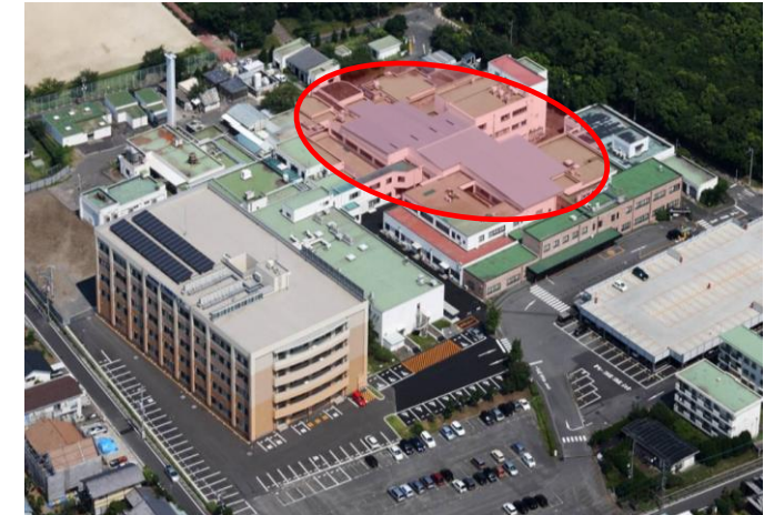
敷地全体(上：解体工事前、下：)解体工事後) 左下は新築病棟)
