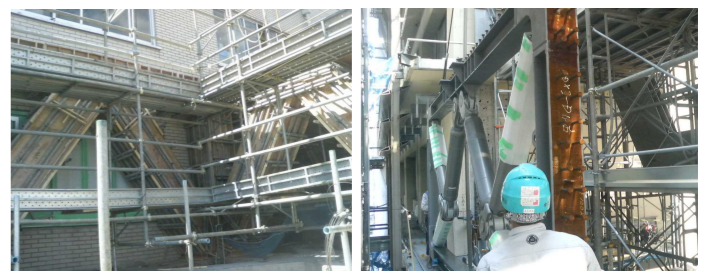
増設SRC架構施工状況 (本庁舎)
