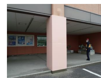
写真-5 柱鋼板巻立補強状況
