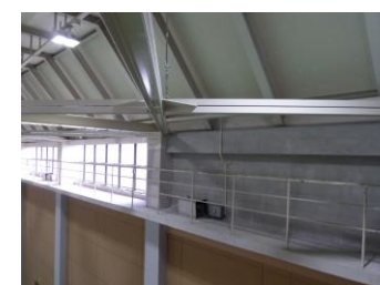
写真-4 4階耐力壁増設補強状況
