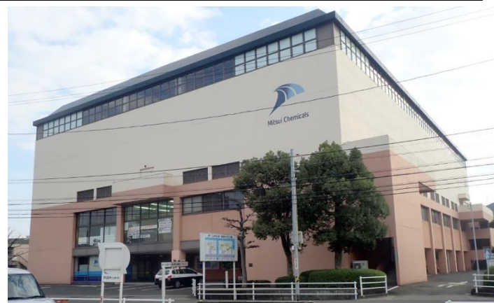
写真-1 建物外観(改修後)
