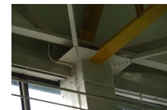
写真-3 柱頭鋼板巻立補強状況
