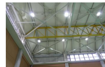
写真-2 屋根鉄骨トラス補強状況
