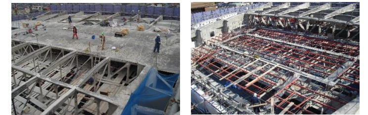
写真-2 既存屋根の解体状況
