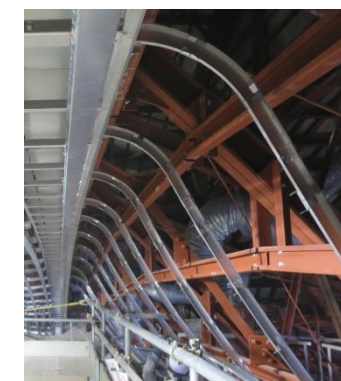
天井下地曲線部
