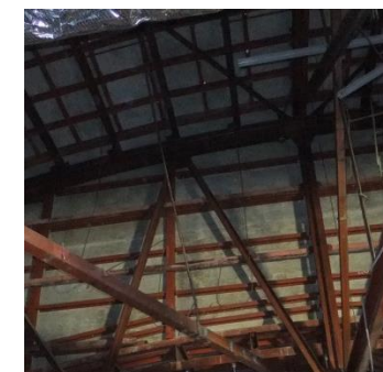
軽量化に伴う屋根、外壁下地
