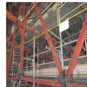
トラス方向天井下地ブレース
