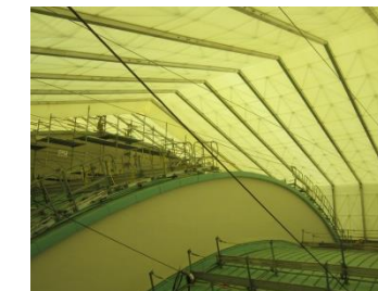
仮設屋根（内観）
