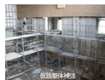
仮設躯体補強
