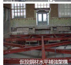
仮設鋼材水平補強架構
