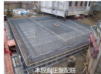
本設耐圧盤配筋
