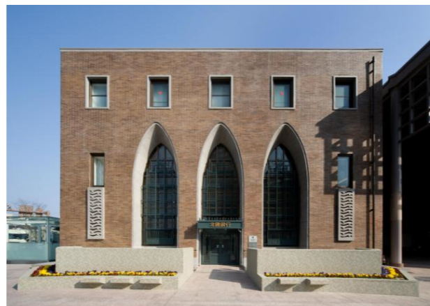
改修後建物外観(改修前と外観はほとんど変わらない)
