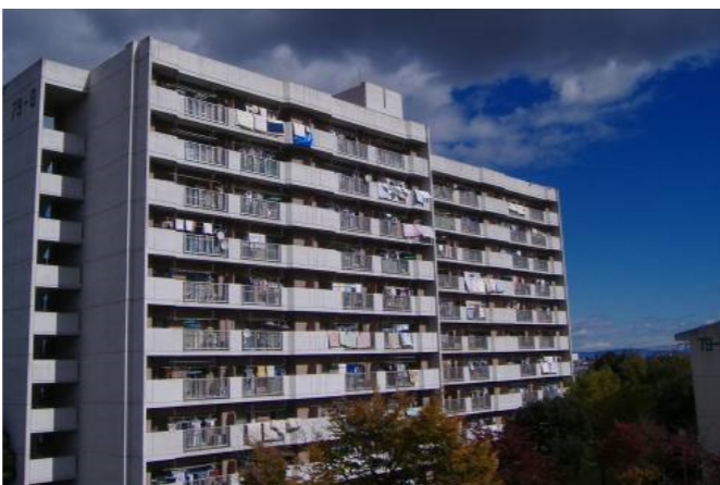
改修前の建物外観
