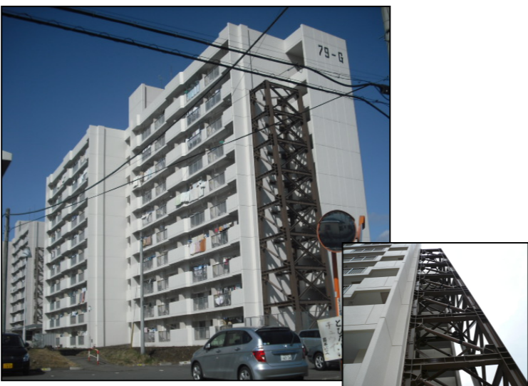
改修後の建物外観
