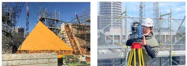
写真-16 3次元測量を用いた型枠建直し
