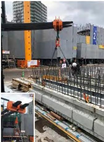
写真-7 PCa 吊り出し状況
