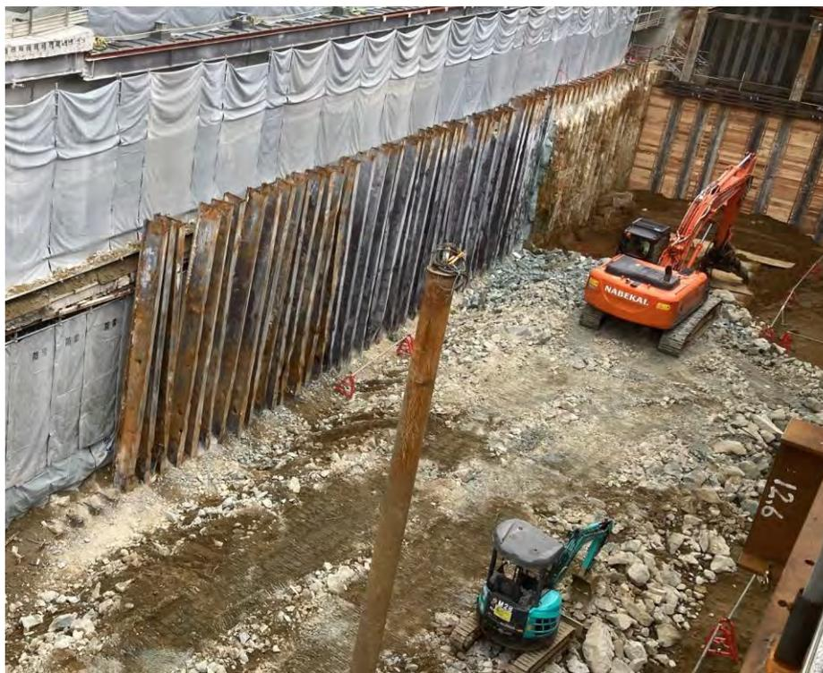
写真 4 従来の SMW 芯材撤去作業状況
