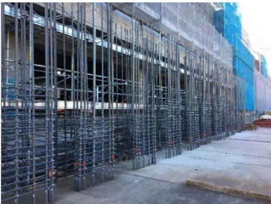
写真-4 柱先組み状況
