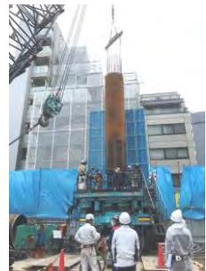
写真-12 鋼管建て込み状況及びスペーサ取付状況
