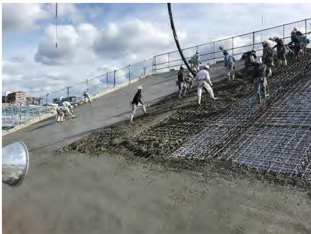
写真-21 24° 勾配でのコンクリート打設状況
