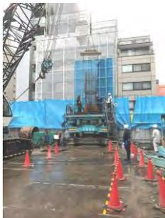
写真-11 鉄筋かご建て込み状況及びレベル確認状況
