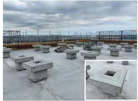
写真-11 屋上設備基礎サイトPC 設置後状況
