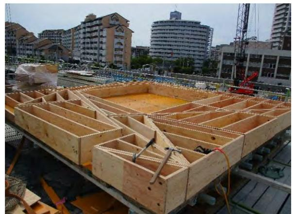
写真-4 骨板を使用した多面体型枠
