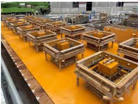
写真-10 屋上設備基礎サイトPCa ヤード状況
