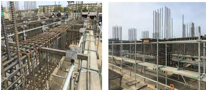
写真3 柱梁一体ユニットの地組み状況
