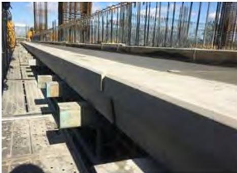
写真-9 底躯体のPCa 設置状況
