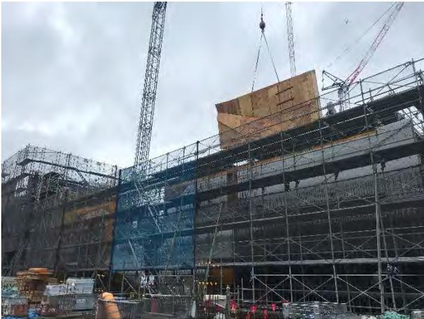
写真-5 多面体型枠吊り込み
