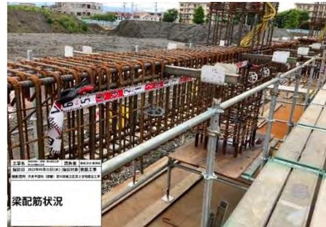
写真10 地組ヤードにおける柱・梁配筋
