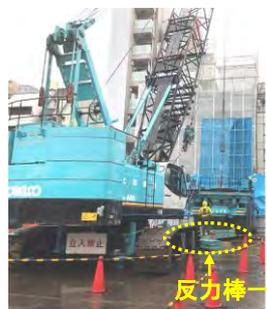
写真-4 CD機設置及びケーシング建込み状況
