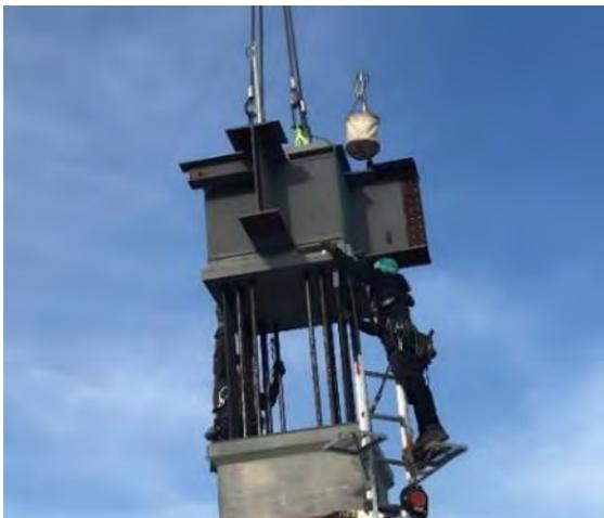
写真-7：仕口セット施工状況
