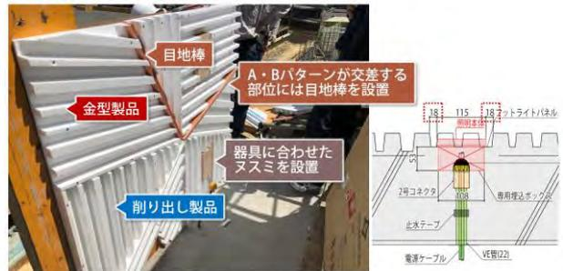
写真-7 モールドスター試験施工
