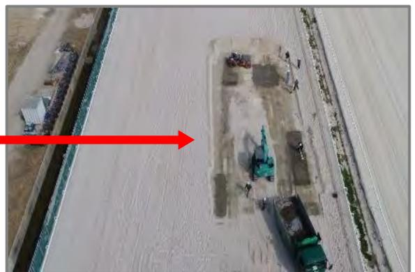
写真-6 路盤厚が薄い箇所補修状況
