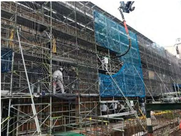
写真-12 打設開口からの打設状況
