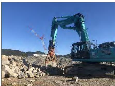
写真 2-1 大割機による破碎
