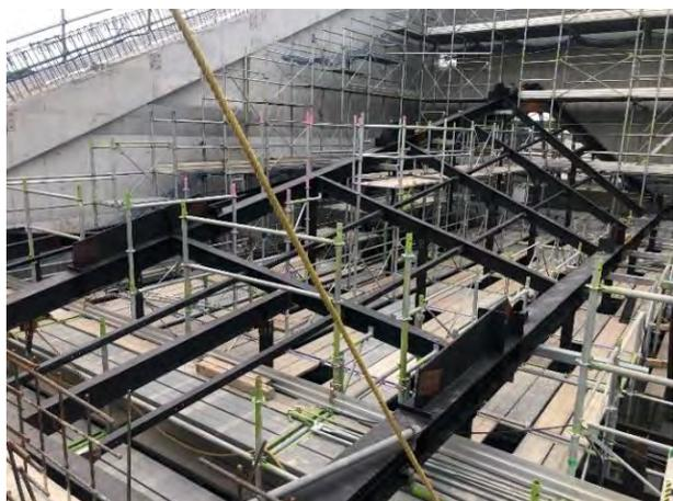
写真-14 仮受支保工を組立後下弦材取付
