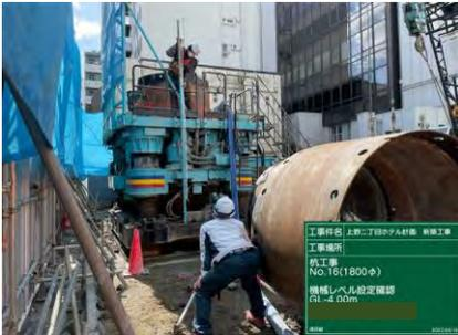
写真-6 設置レベル確認状況
