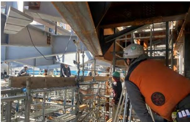
写真-7 ジャッキダウン時のたわみ測定状況
