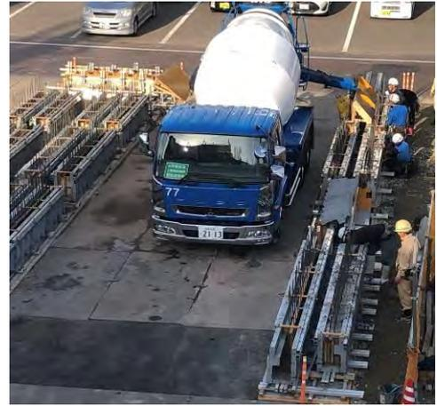
写真-6 PCa 打設状況
