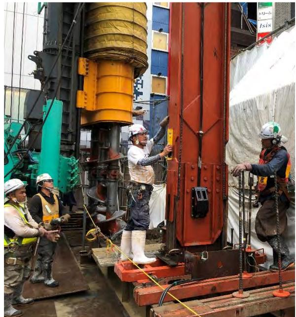
写真 1-1 落とし込み工法施工状況
