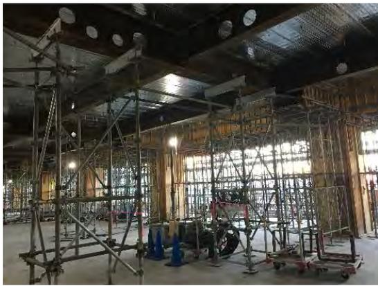
写真-5 クサビ支保工システム設置状況
