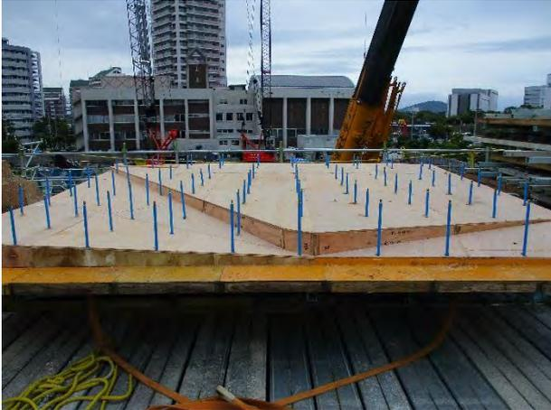
写真-9 チューブコーンを使用した多面体型枠
