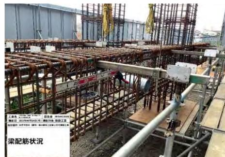
写真11 地組ヤードにおける配筋検査状況
