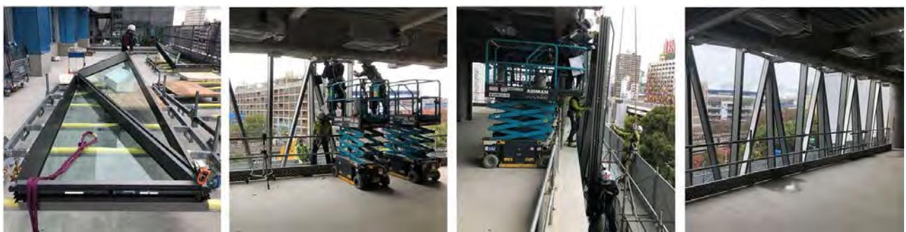
写真2 中層階 ACW 施工状況写真
