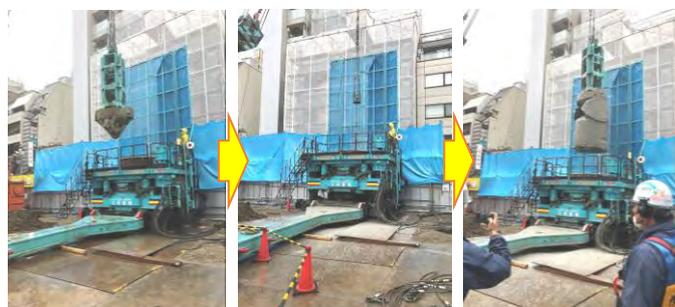
写真-5 ハンマーグラブによる既存杭撤去状況
