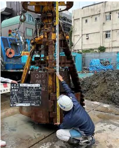
写真-9 拡底バケット確認状況
