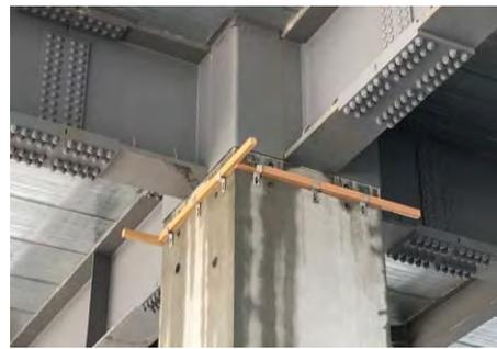
写真-3：レンコン形式の柱・仕口の施工状況      写真-4：接合部のグラウト用型枠
