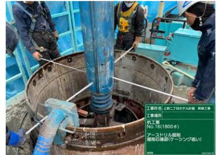
写真-8 掘削心確認状況
