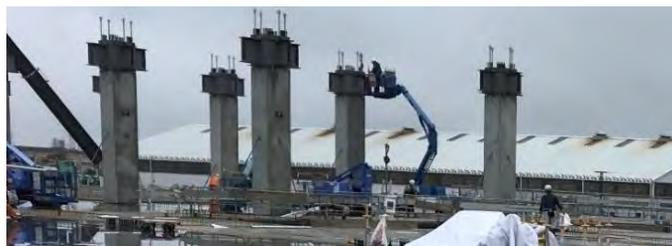
写真-5：コンクリートスラブ上に高所作業車を載せての施工状況
