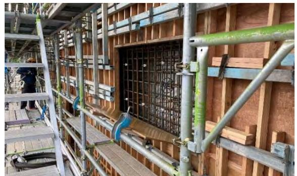
写真-11 パネル割りに合わせた打設開口
