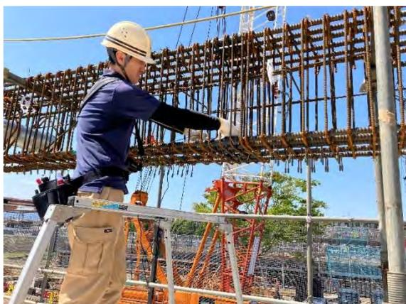
写真12 継手部外観検査状況
