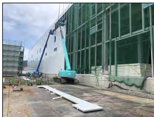
写真 5-2 外壁取付(パネル取付)
