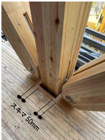
写真—3 ブレース取り付け
