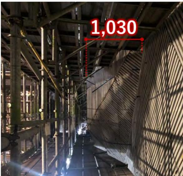
写真-10 多面体最大凹凸差
