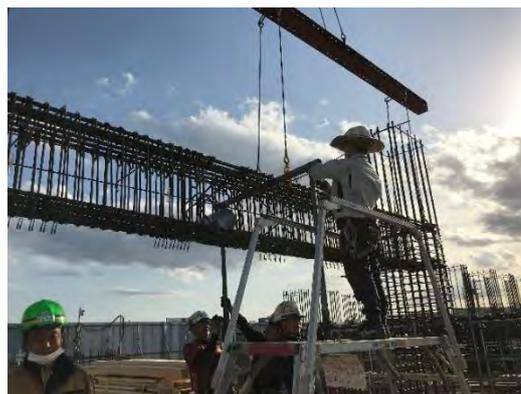
写真7 角パイプ・パイプサポート使用梁受け架台設置状況
