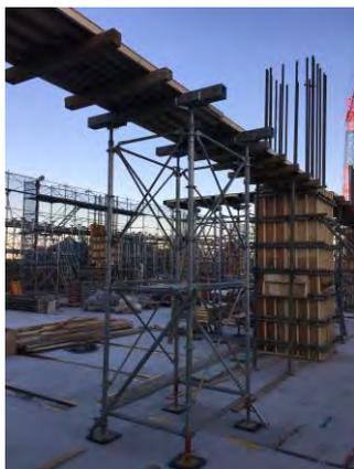
写真-6 支保工ブロックの配置状況
