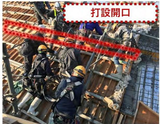
写真-23 打設開口を使用したコンクリート打設状況
