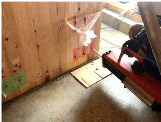
写真-11 GIR 接合注入工事
