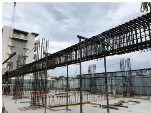
写真8 角パイプ・パイプサポート使用梁受け架台設置完了
