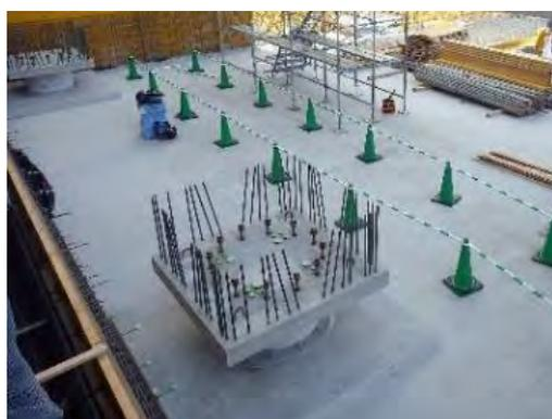
写真-5 免震基礎上部ハーフ PCa 設置状況
