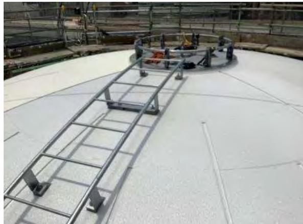
写真-11 頭頂部防水施工状況
