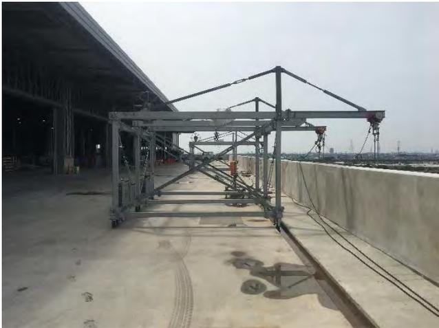
写真-6 パネル揚重機システム設置状況
