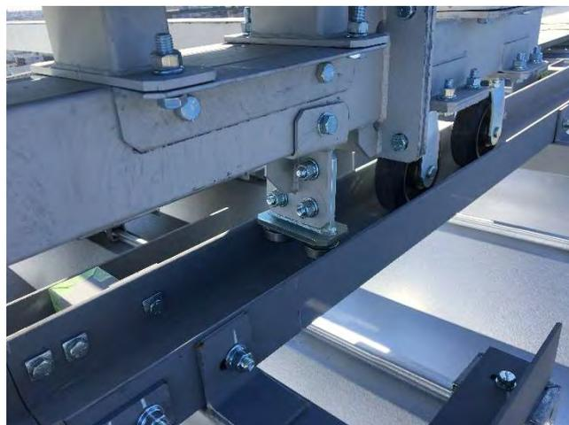
写真-5 移動台車走行レール取付け状況
