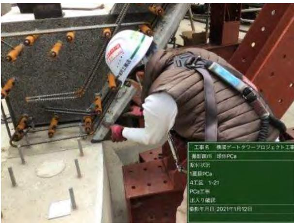
写真-8 基礎と第1層PCa版の取合い接続状況
