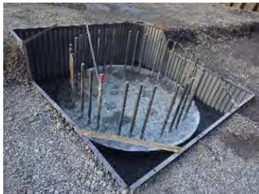
写真-4 鋼製型枠設置状況
