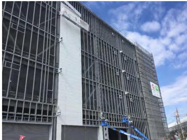
写真-3 外壁パネル施工状況
