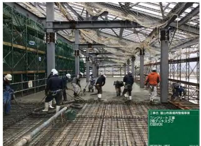
d) 2階床コンクリート打設
