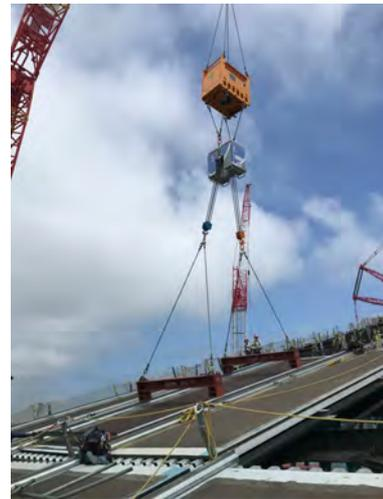
写真-4 屋根ユニットの取付状況
