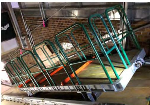
写真 2. 開発した揚重装置の台車部分
