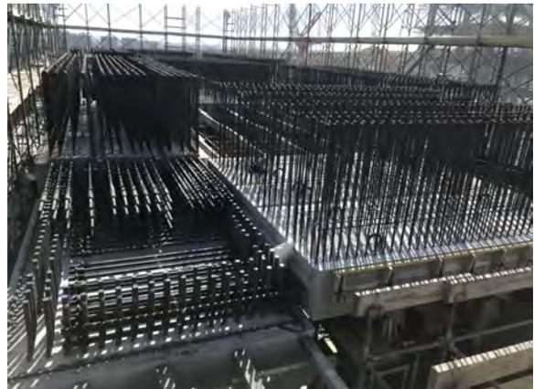
写真-2 ナックル PCa 設置状況
