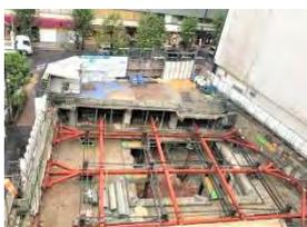
写真-1 1段切梁架設完了
