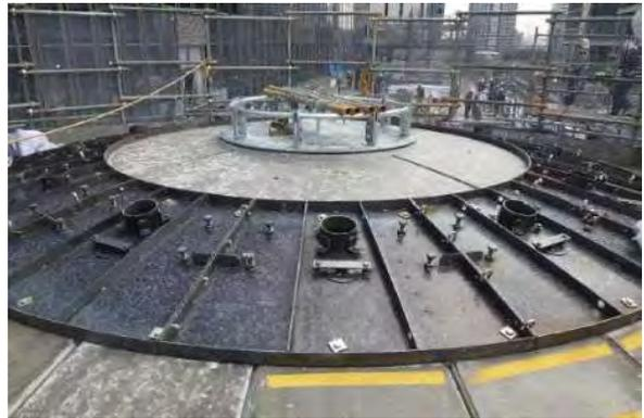
写真-10 第3層と蓋取合い型枠取付け状況
