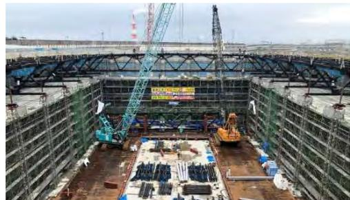
写真10 中央部鉄骨トラス取付け
