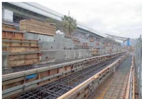
写真5 PCa 部材据付後
