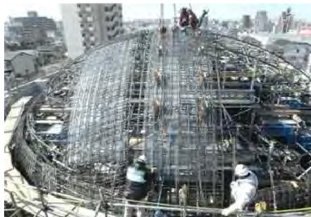
写真-4 ニュートラスウォール工法事例
