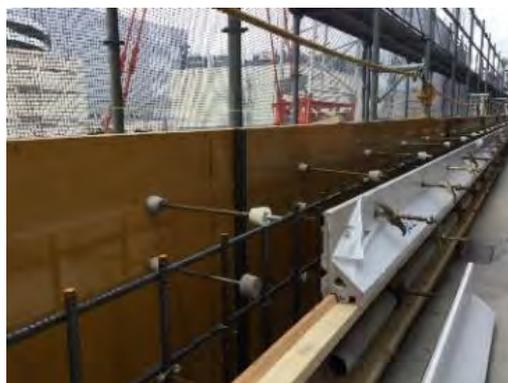
写真-7 押出成形セメント板設置状況
