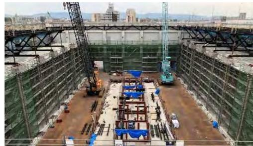
写真9 両端部鉄骨トラス地組、取付
