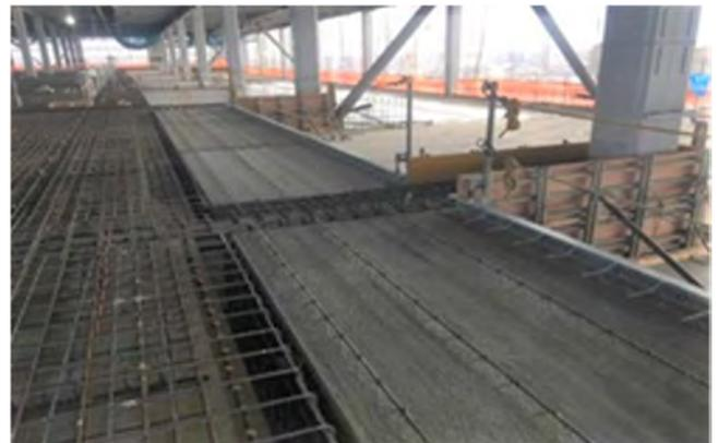
写真-11 トラックバース跳ね出しスラブPCa設置状況
