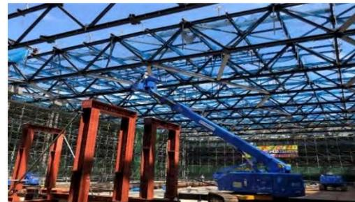
写真11 鉄骨トラス本締め
