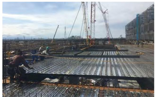
写真-10 鉄筋トラス付きデッキ設置状況
