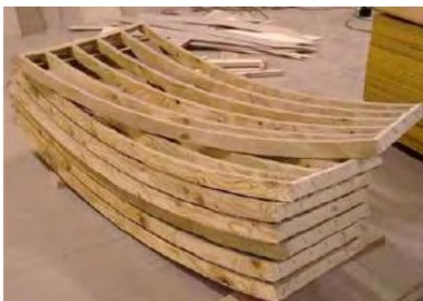
写真-3 在来壁現場打ち曲面型枠
