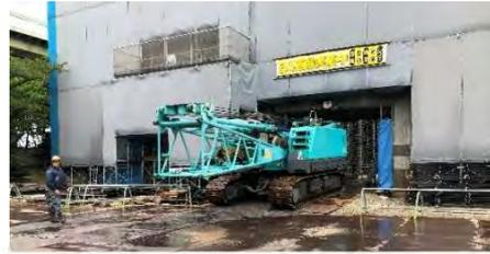
写真12 仮設開口からの揚重機搬出
