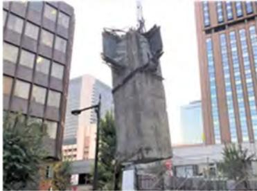
写真-3 柱ブロック解体
