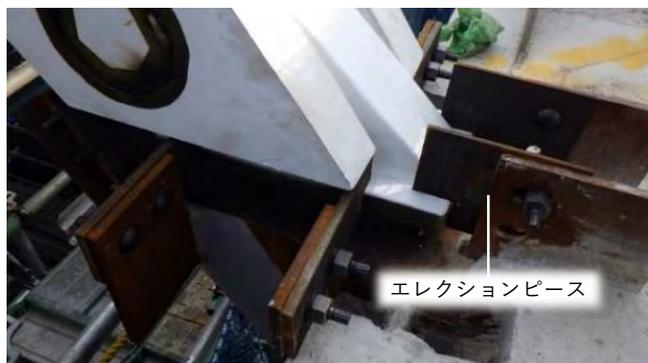
写真7 エレクトロンピースによる柱脚部仮固定
