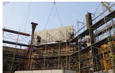
写真8 垂れ壁PCa 部材据付状況
