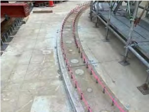
写真-7 基礎と第1層PCa版接続筋打込み状況
