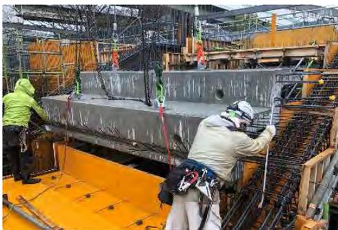
写真4 PCa 部材据付状況
