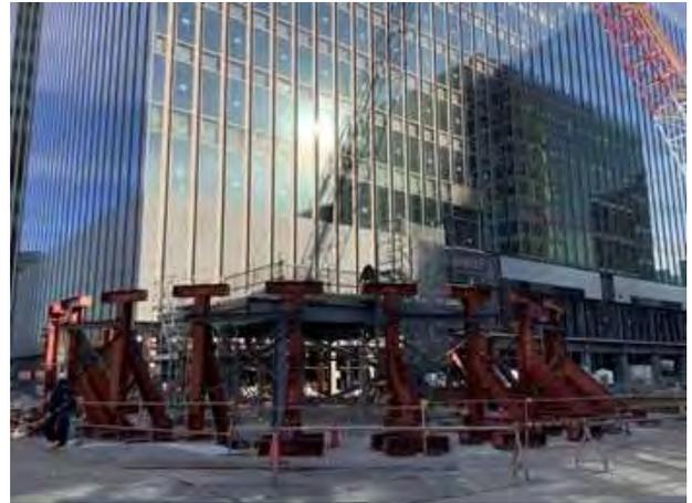
写真-16 1層目PCa受け架台施工状況
