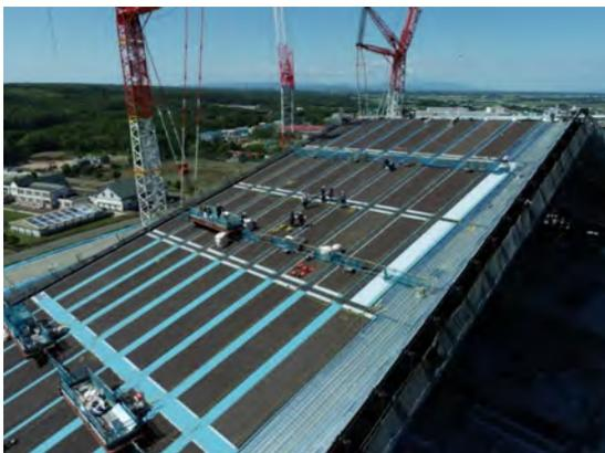
写真-5 屋根ユニット間の防水状況
