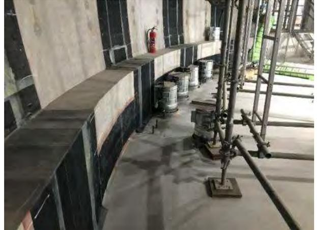
写真-13 内部シート防水施工状況
