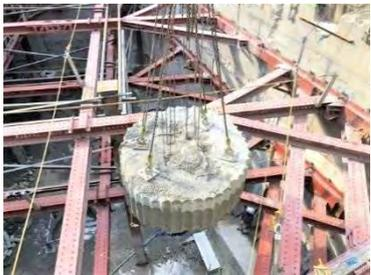
写真-4 耐圧版連続コア抜き解体
