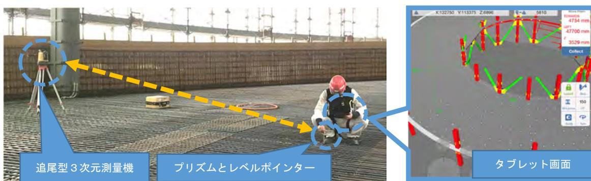
図-5 コンクリート打設前のレベル設置作業
