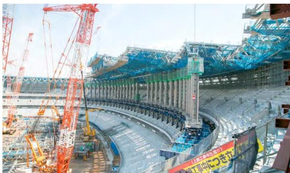
写真-3 T-CAPS架設・フィールド状況
