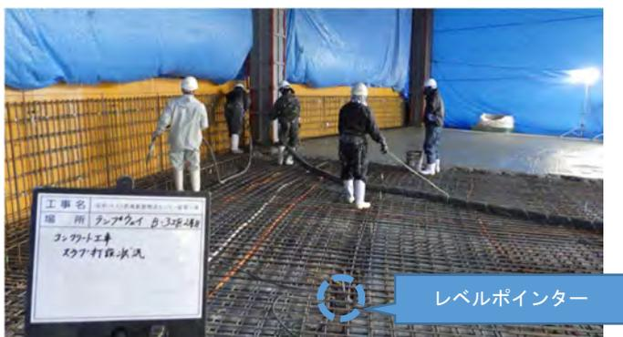
写真-2 コンクリート打設中(1)
