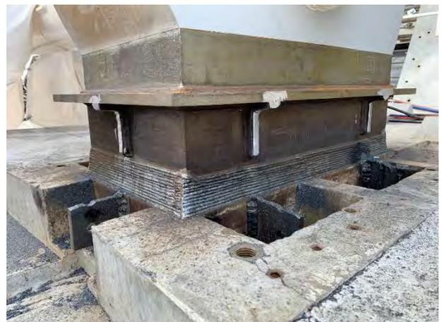
写真-13 アーチトラス脚部溶接
