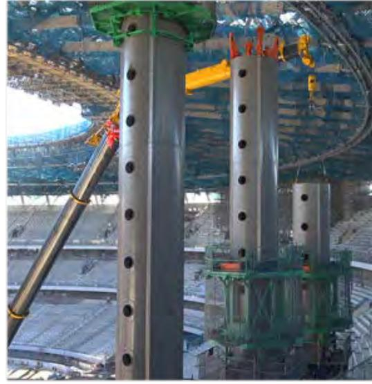
写真-6 T-CAPSクレーンによる解体
