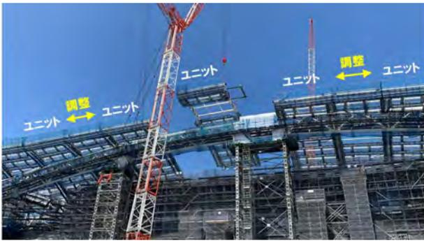
写真-5 屋根面鉄骨 建方状況
