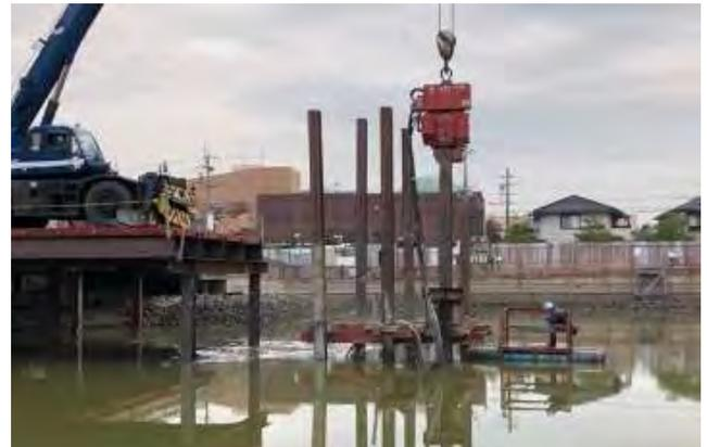
写真3 超高周波型バイブロハンマによる打設
