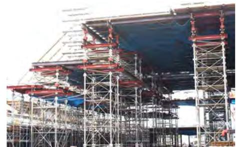
写真17 パイプ支柱システム支保工
