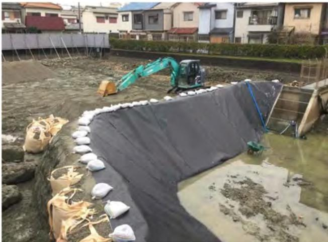
写真5 大型土嚢と遮水シートによる堰堤
