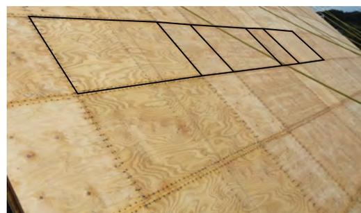
写真19 屋根野地板施工
