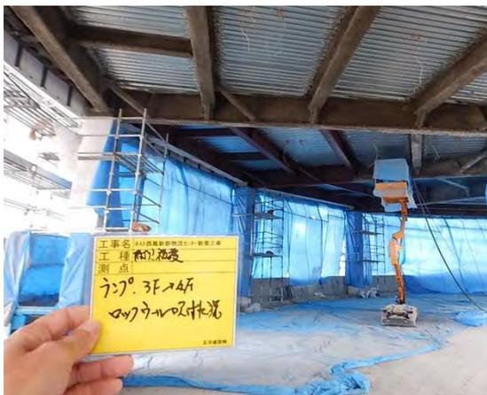
写真-4 傾斜地対応型の高所作業車
