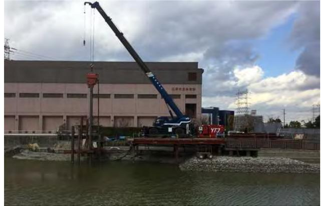
写真2 支持杭打設状況
