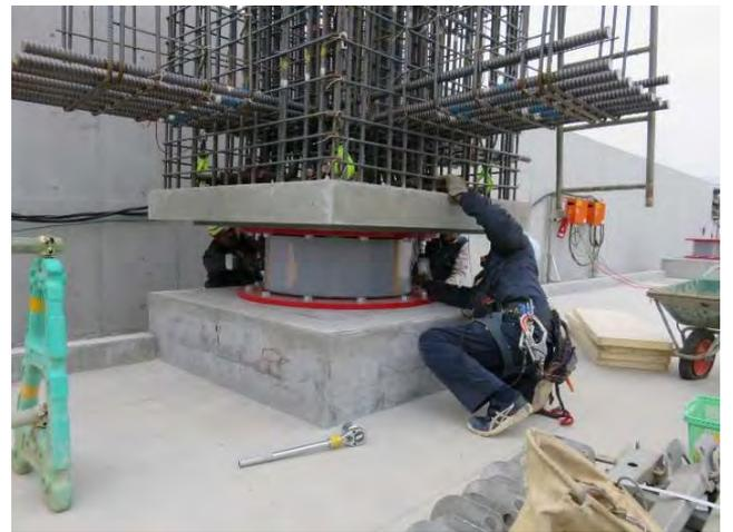
写真-11 免振上部基礎ユニット設置
