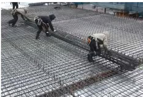
写真-1 ロールマット工法(幅 12m)
