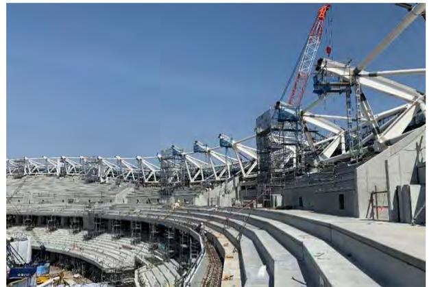
写真-7 外周リングトラス建方完了状況
