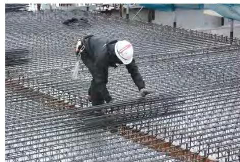
写真-2 ロールマット工法(幅 1.75m)
