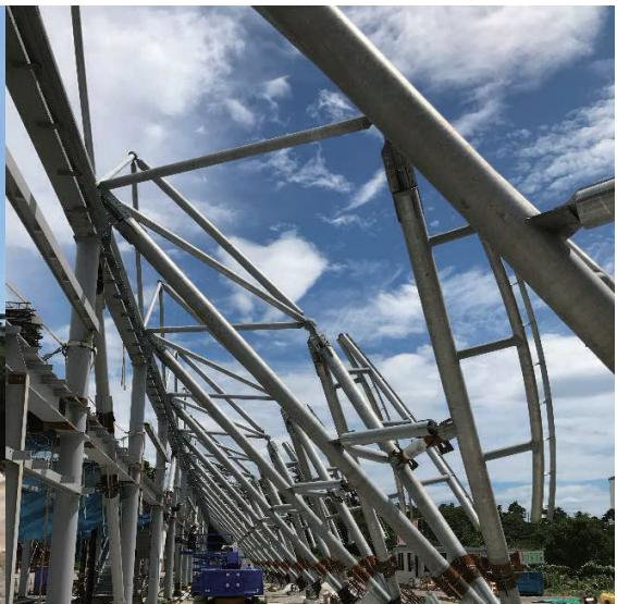
写真－7 柱脚部鉄骨組立状況
