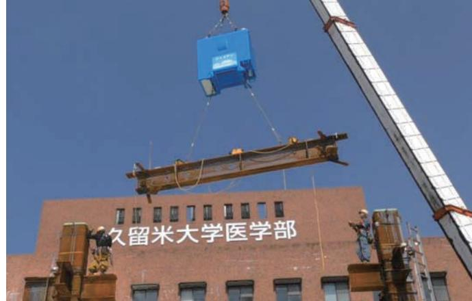
写真-11 吊荷旋回制御装置使用状況
