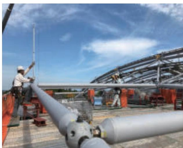
写真—8 鉄骨ジョイント レベル測定
