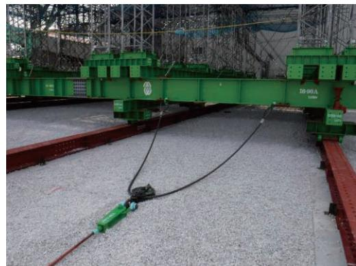
写真－13 牽引治具取付け状況
