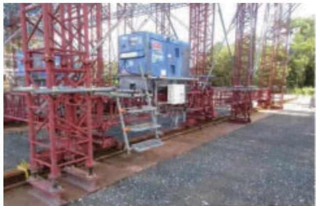
写真－11 移動式支保工足場ジャッキポスト&レール
