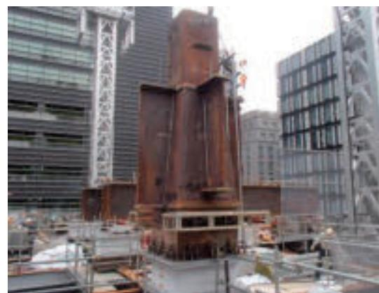
写-3 免震上部鉄骨設置状況
