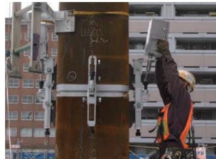
写真-9 柱自動建入装置取付状況
