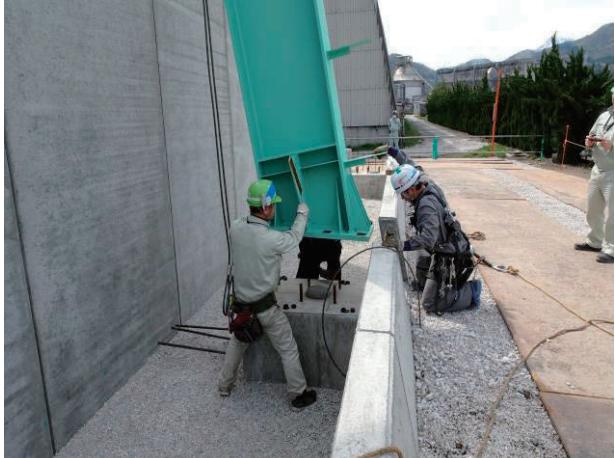
写真－7 柱脚据付状況
