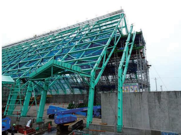
写真－8 斜めトラスユニット据付完了
