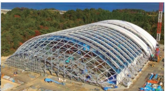
写真－13 鉄骨建方完了 & 屋根膜 展張
