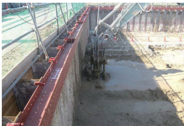
写真-4 頭繋ぎ補強状況
