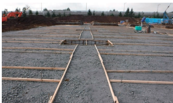
写真-3. 掘削床付け状況
