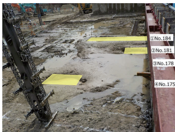
写真-5 5月15日 施工状況
