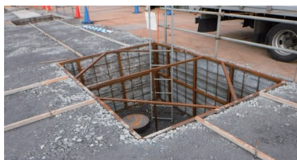
写真-5. 基礎鋼製ラス型枠施工状況
