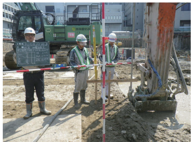
写真-3 マーキングによる改良深度確認
