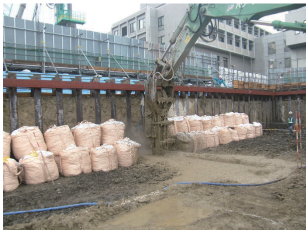
写真-6 フレコンバッグ土嚢2段積み
