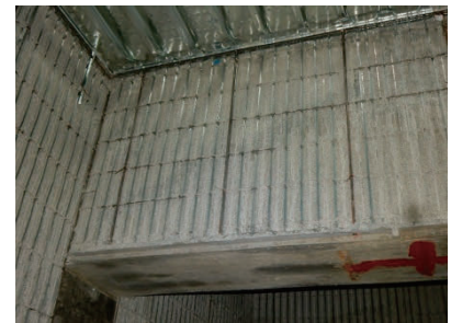
写真-11. フラットデッキ下打設後
