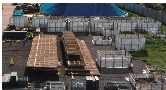
写真-7. 外周ユニット型枠および基礎鋼製ラス型枠
