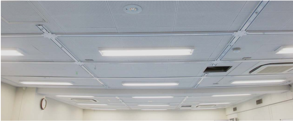
写真11 T-Ceiling Grid 設置状況①
