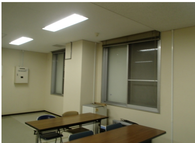
写真-10 補強壁施工完了 (室内側)
