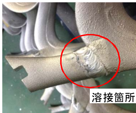
写-4 束材溶接部
