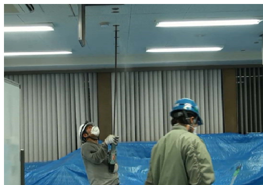
写真8 あと施工アンカー打設状況
