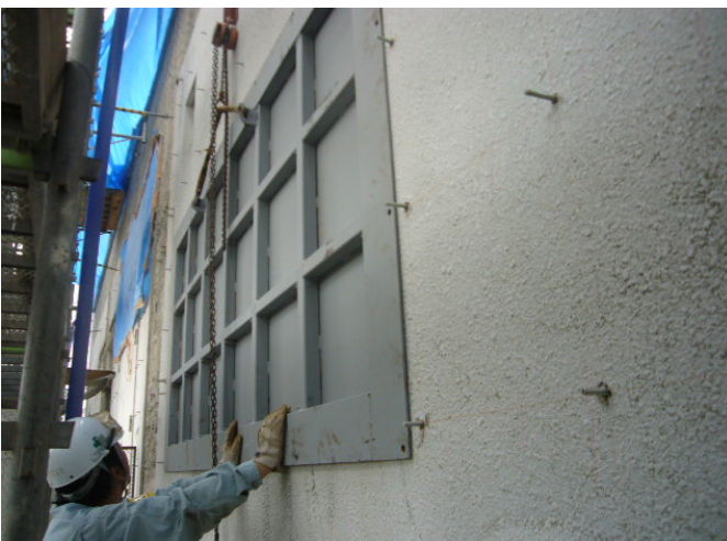
写真-4 鋼板取付状況
