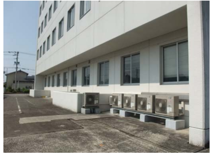
写真-1 外部施工前
