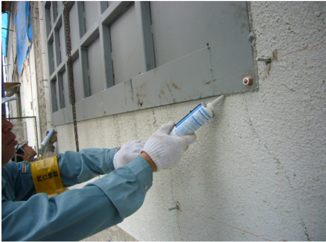
写真-6 シーリング施工状況
