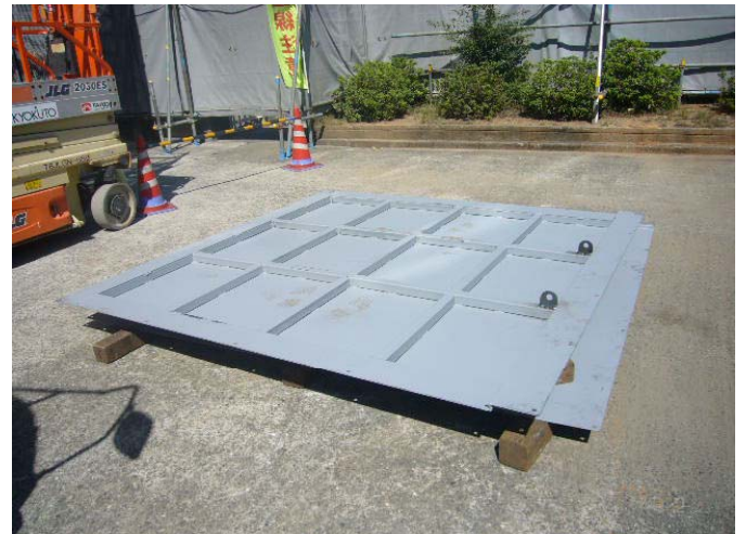
写真-3 窓塞ぎ鋼板
