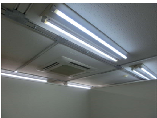
写真5 設備機器を避けた配置
