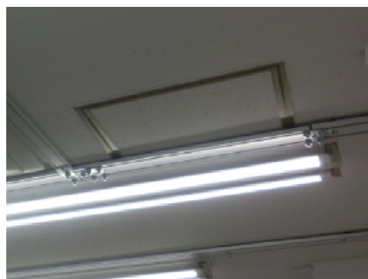
写真6 点検口の納まり
