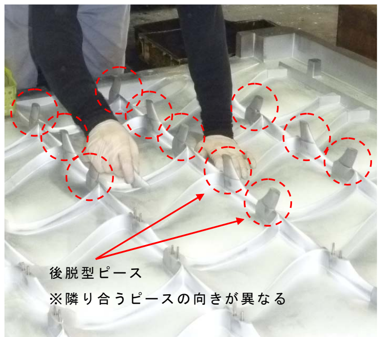
写-5 後脱型ピース取付状況
