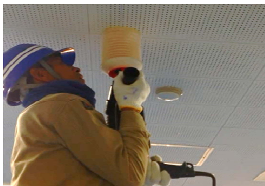
写真7 集塵機を用いた削孔
