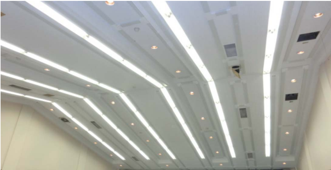
写真12 T-Ceiling Grid 設置状況②
