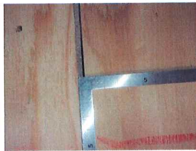
写真10 ②捨てベニヤ隙間状況
