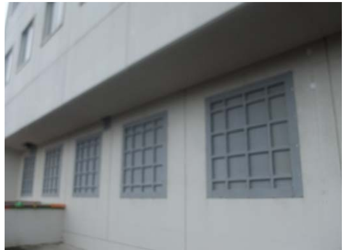
写真-7 窓塞ぎ鋼板取付状況
