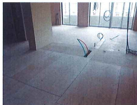
写真6 床先行間仕切り前状況
