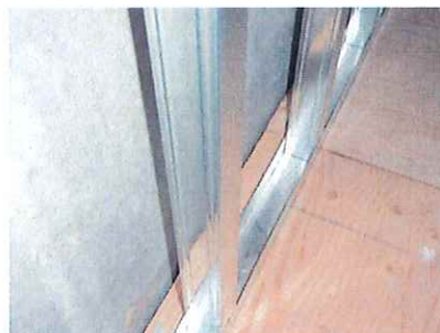
写真14 ①増かし壁部状況
