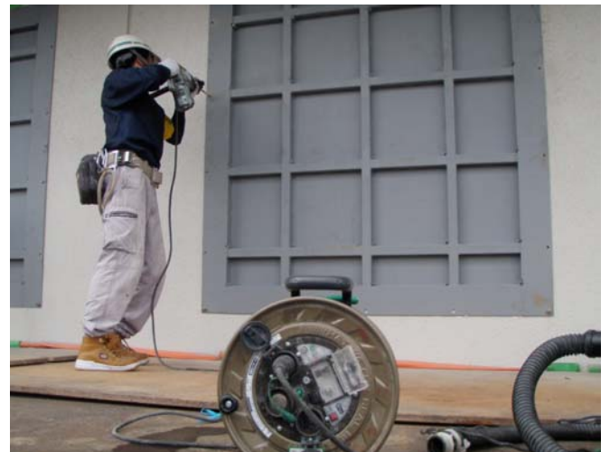
写真-5 アンカー打設状況
