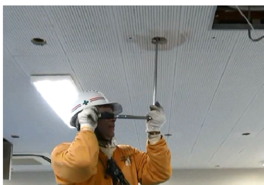
写真9 トルク管理によるアンカー定着
