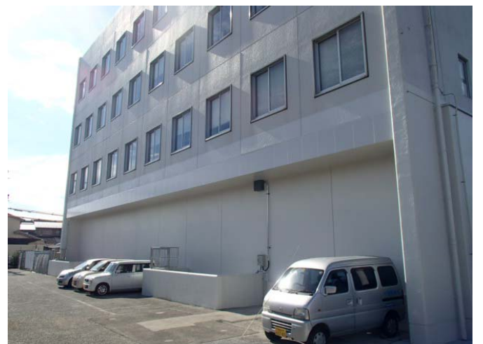
写真-9 補強壁施工完了
