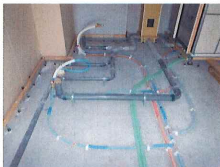
写真5 壁先行間仕切り壁前状況
