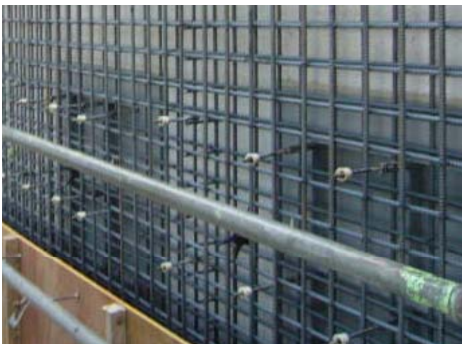
写真-8 補強壁配筋施工状況
