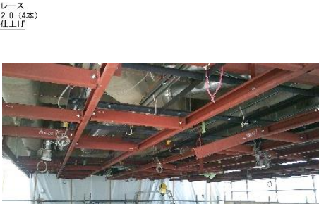
写真9 天井鉄骨下地施工状況
