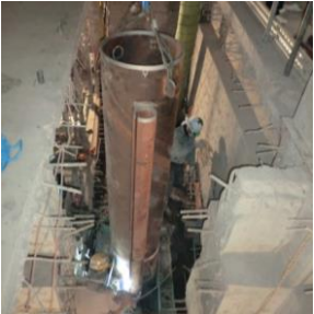
鋼管矢板の施工
