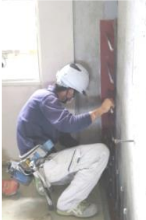
接合筋付き鋼板取付け状況
