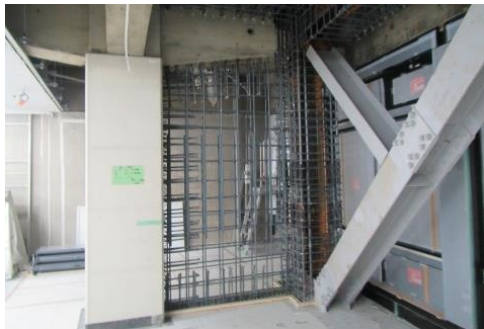
補強壁、ブレース設置状況（施工中）
