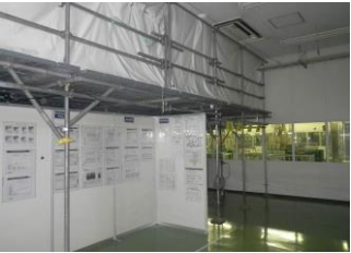
屋根面水平ブレース用棚足場
