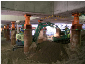
直接基礎撤去後の掘削
