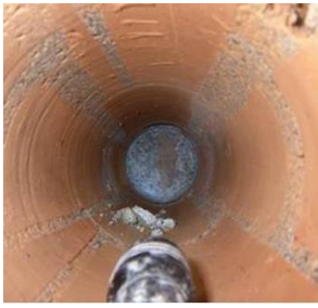
写真5 鉄筋挿入孔φ64
