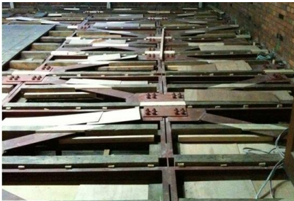
写真4 床面鉄骨補強
