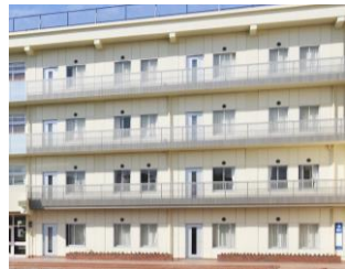
鉄骨フレーム補強後・校舎外観
