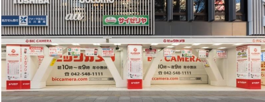
改修後補強ブレース外観（店舗入り口部分）
