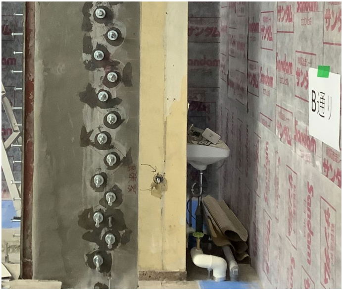
写真4 柱部ディスクシアキーと工事用仮設間仕切り壁
