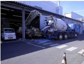
1 階補強壁コンクリート打設状況
