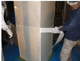
ポリエステル柱巻立て工法（SRF工法）
