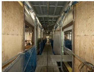
写真 6 新設壁合板貼り
