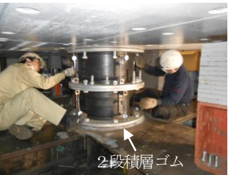
制振装置設置状況
