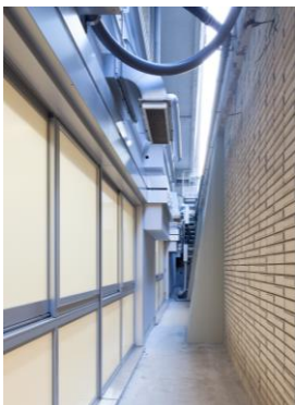
既存ドライエリアを 免震ピットに改造
