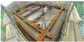
⑥錘コンクリート打設状況
