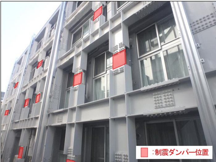
写真-3 制震フレーム
