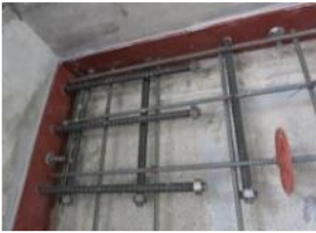
接合筋付き鋼板
