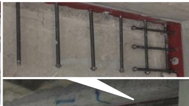
接合筋付き鋼板取付け状況
