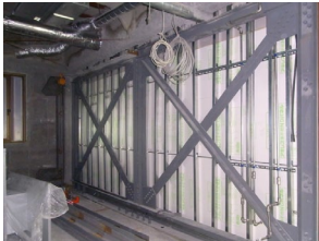
写真 2 鉄骨ブレース新設
