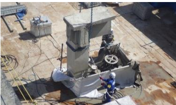
写真-5 柱切断状況
