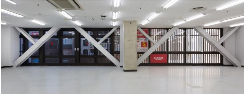
改修後外周部補強ブレース内観（西側）
