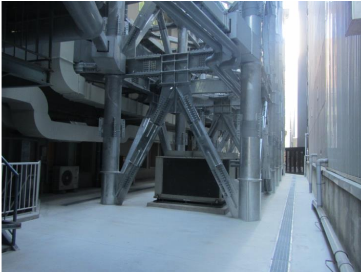
耐震鉄骨補強完成（下部）
