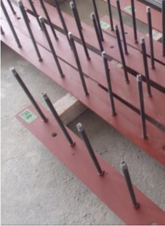
接合筋付き鋼板
