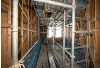
写真 10 メール室（筋交い新設後）
