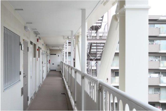
制震ブレース取付状況（廊下）
