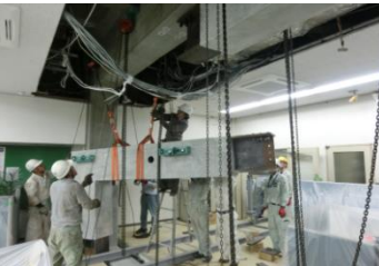
写真5 チェンブロックによる取付け
