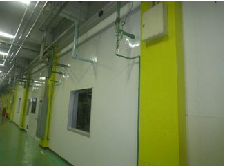
1 階耐震壁設置後
