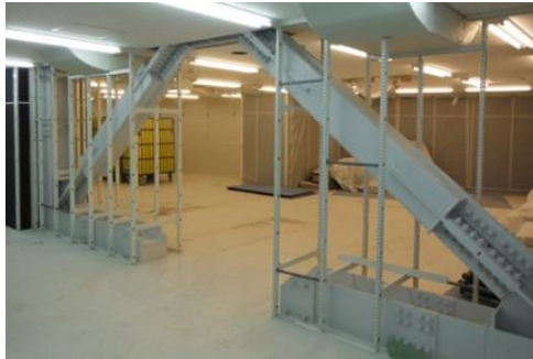
補強ブレース設置状況（施工中）
