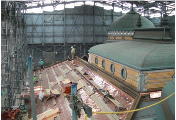
写真8 屋根銅板葺き替え工事
