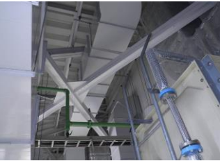
屋根面水平ブレース設置後
