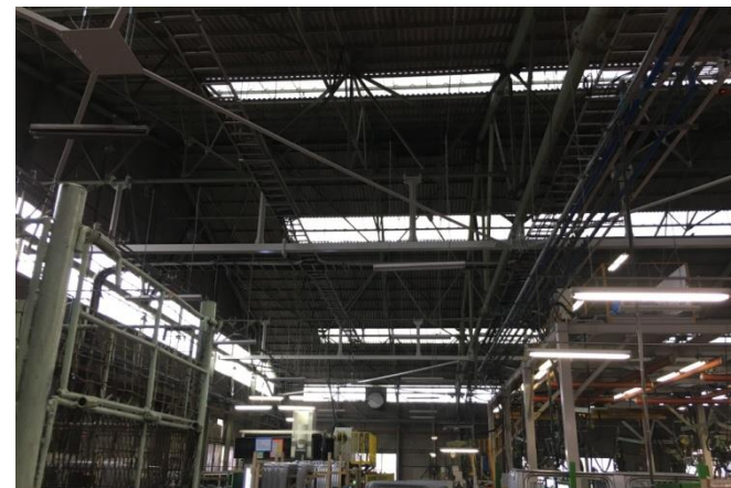
屋根ブレースおよび補強設置後
