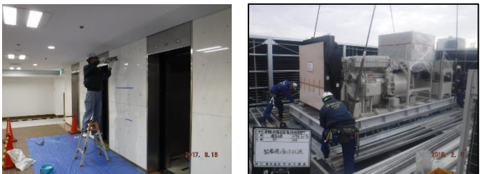
図-7 石壁剥離防止工事・非常用発電機設置工事
