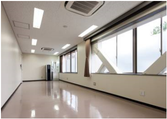
鉄骨ブレース（ハイブリッド）耐震補強工法
