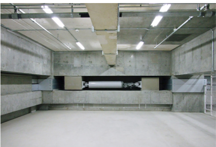
オイルダンパー設置完了
