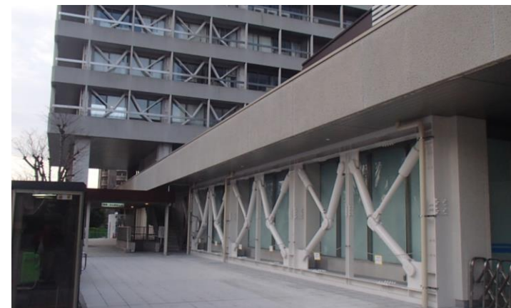
外付補強架構（トグル制震ブレース）
