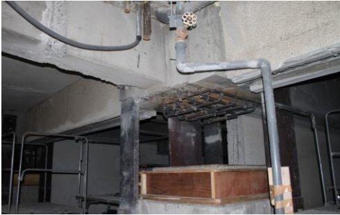
既存柱の切断時の様子
