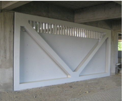
3Q-Brace 工法 完了状況
