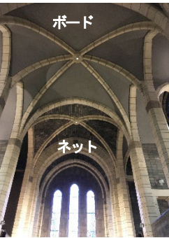
写真9 ボード天井とネット部分
