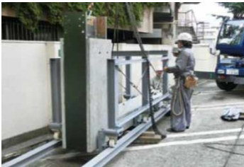
写真4 レールと台車による搬入
