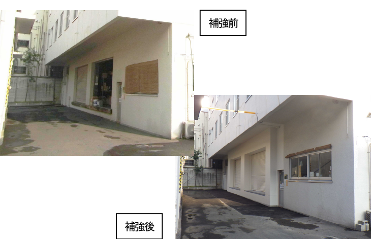
写真－3 MaSTER FRAME (マスターフレーム) 構法 補強前後写真
