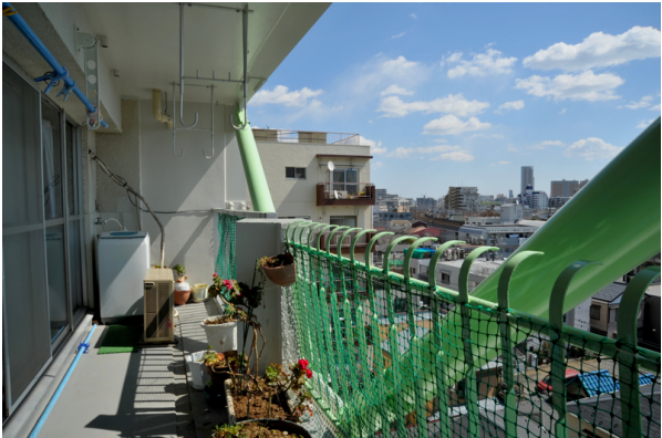
制震ブレース取付状況（バルコニー内部）
