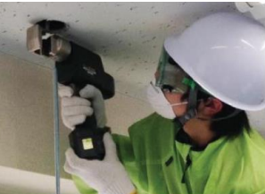
4) 吊りボルト設置
