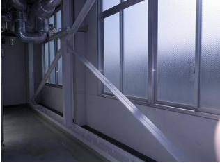
2 階垂直ブレース設置後
