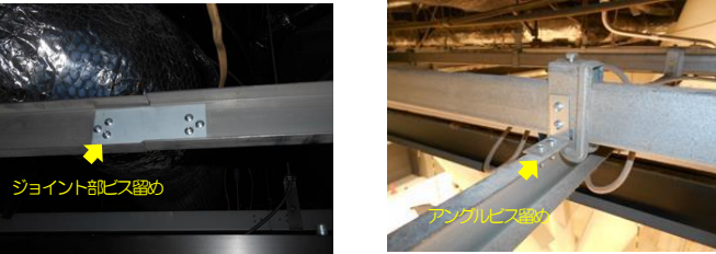
写真 4 下地材の補強 状況
