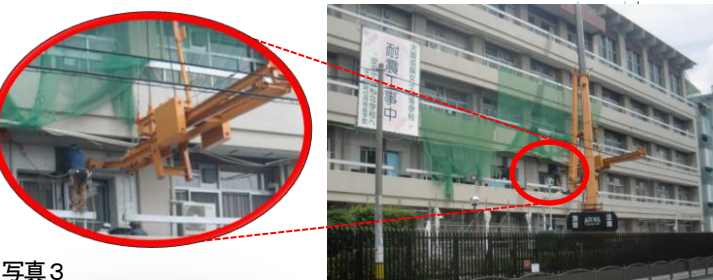
写真 3 マジックビーム（吊り荷重心調整機能付き吊りビーム）を使用して 施工中の 1 号館南面外観
