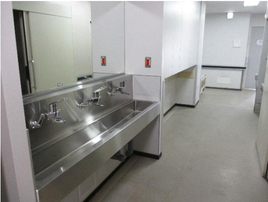
改修後 洗面・収納背面に 3Q-Wall 増設後、復旧
