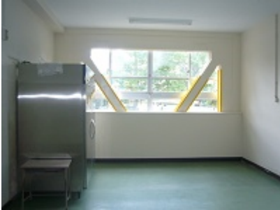
枠付き鉄骨ブレース（配膳室）
