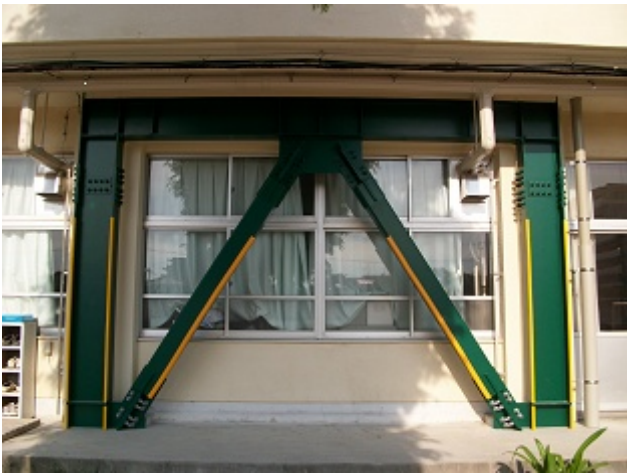
外付け鉄骨ブレース（外壁）
