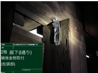
写真 5 接合部補強金物取付状況
