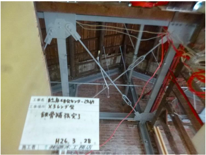
煉瓦壁及び小屋組 鉄骨補強状況
