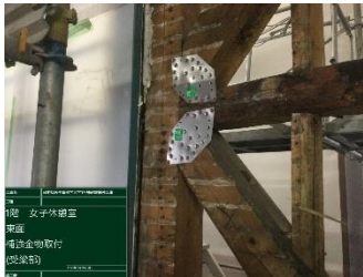
写真 4 接合部補強金物取付状況
