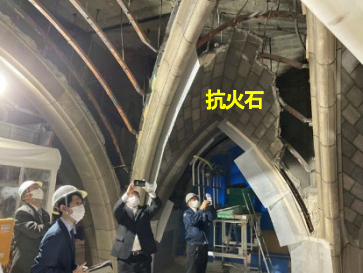
写真3 天井抗火石解体
