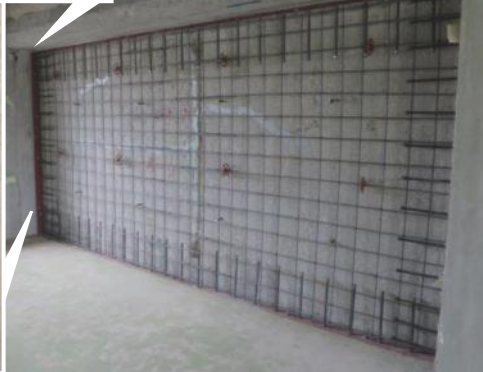
接合筋付き鋼板取付け・配筋完了
