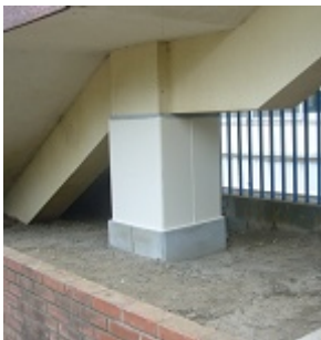
柱鋼板巻き立て（外階段）
