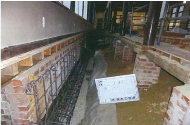
煉瓦基礎補強状況
