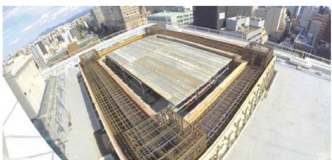
②TMD 基礎配筋、型枠状況
