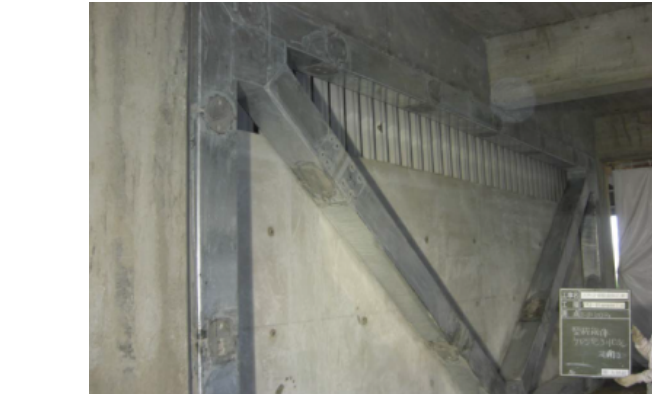
3Q-Brace 工法 仕上げ前 完了状況
