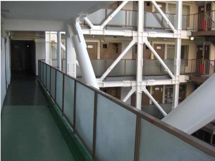
鉄骨ブレース取付(手前廊下側)・制震ブレース取付状況（奥廊下側）
