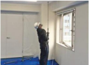
2) アンカー一部削孔
