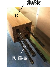
写真-5 ブレースの構成
