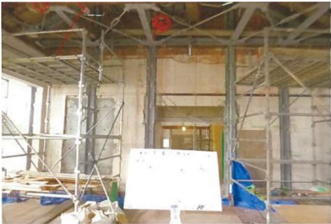
煉瓦壁及び小屋組 鉄骨補強状況
