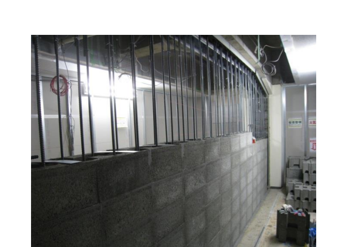
仮間仕切り内部での3Q-Wall 施工
