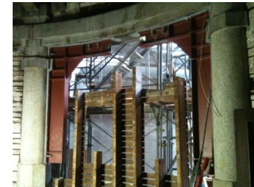
（鉄骨フレーム補強）
