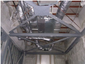
写真 3 屋根面の鉄骨水平ブレース
