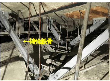
写真6 振れ止め補強
