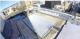
①屋上防水層撤去、あと施工アンカー打設状況
