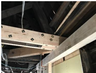
写真 8 屋根受梁腐朽部（補強後）
