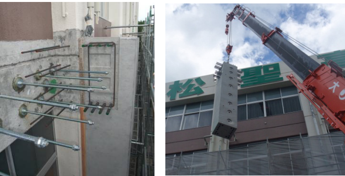
ディスクアンカー施工状況
