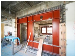
鉄骨フレーム補強・施工状況
