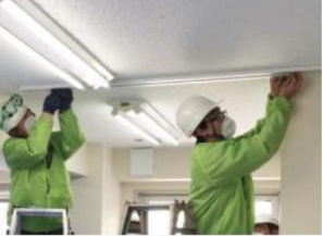
6) 水平支持部材設置
