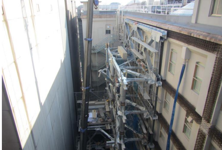
外部補強、鉄骨建方施工状況
