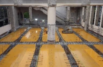
写真-5 梁及びスラブ（施工中）
