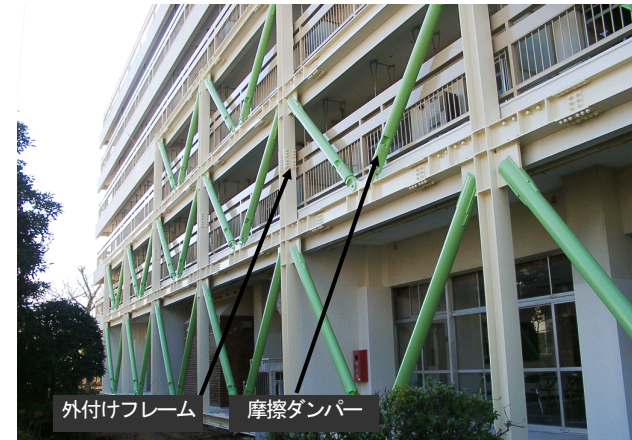
制震ブレース取付状況
