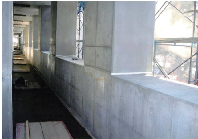
アウトフレーム補強内部施工状況
