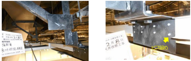
写真 3 水平移動拘束材の取り付け状況
