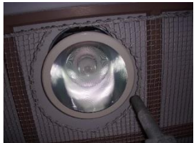
写真7 落下防止ネット設置状況
