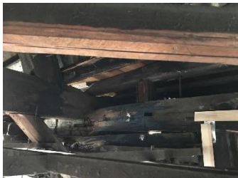
写真 7 屋根受梁腐朽部（補強前）
