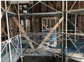
写真 3 筋交い新設状況
