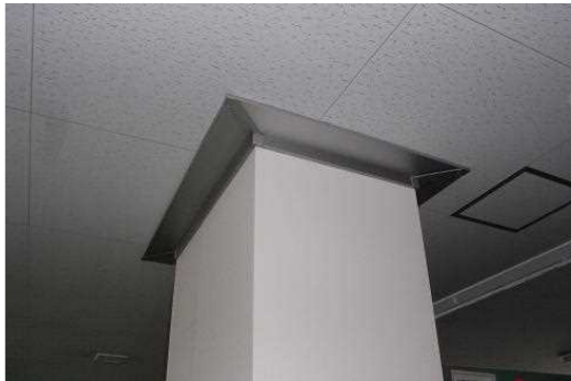
天井材と柱のクリアランス(カバー付き)
