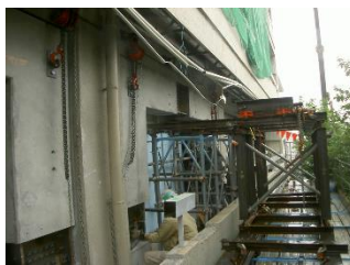
写真 6 先組した SMIC 部材 2 ピースを一度 に運べ、建物の直角方向へも移動 できるように改良した台車
