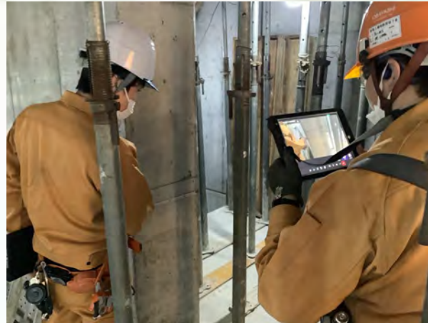
隠蔽前出来形検査
