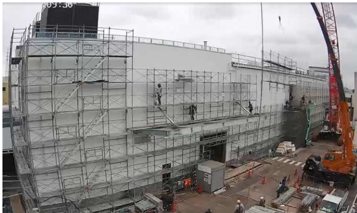
外部足場解体中
