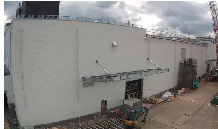
外部足場解体完了
