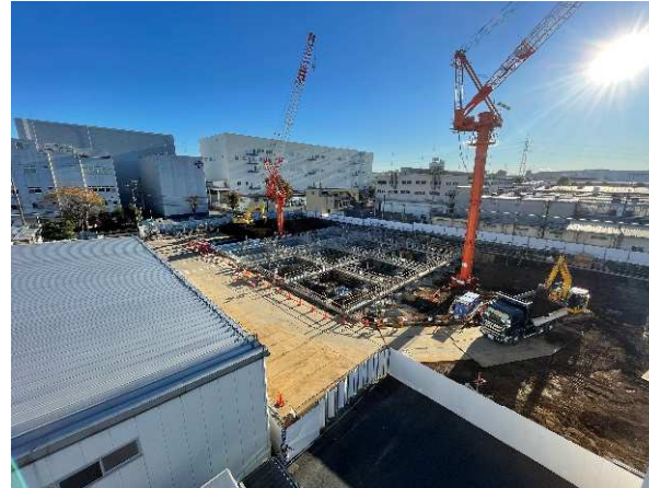
躯体が出来たら埋める
