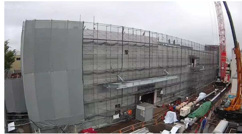
現場成型折板屋根葺き
