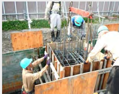
④鉄筋・型枠ユニット設置
