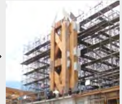
先組み部材の建方
