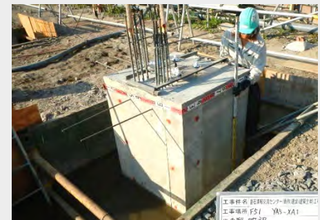
⑥コンクリート打設
