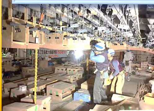
クイックデッキ上での作業
