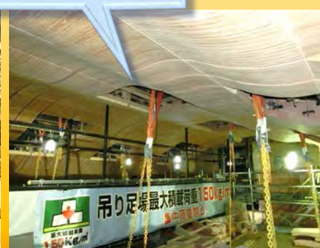
クイックデッキ吊り元
