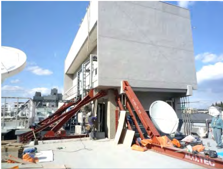
塔屋 緊急補強 （山留め材）
