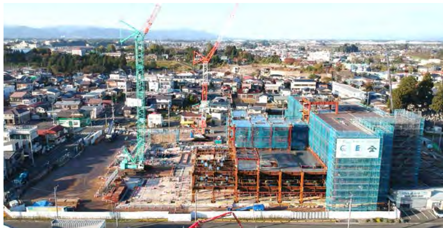
病院・特定施設棟（10/25現在）
