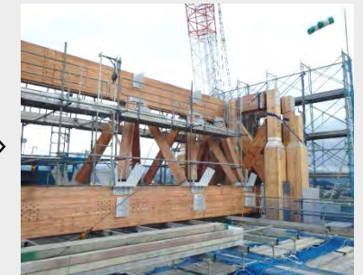
立体トラス梁の設置
