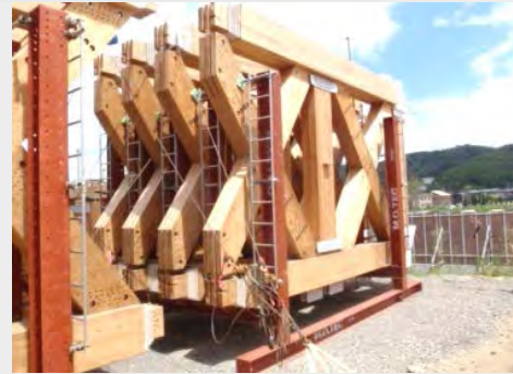
柱先組み部材のストック
