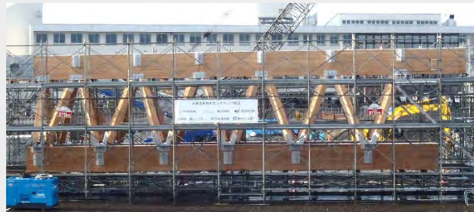
立体トラス梁の地組み
