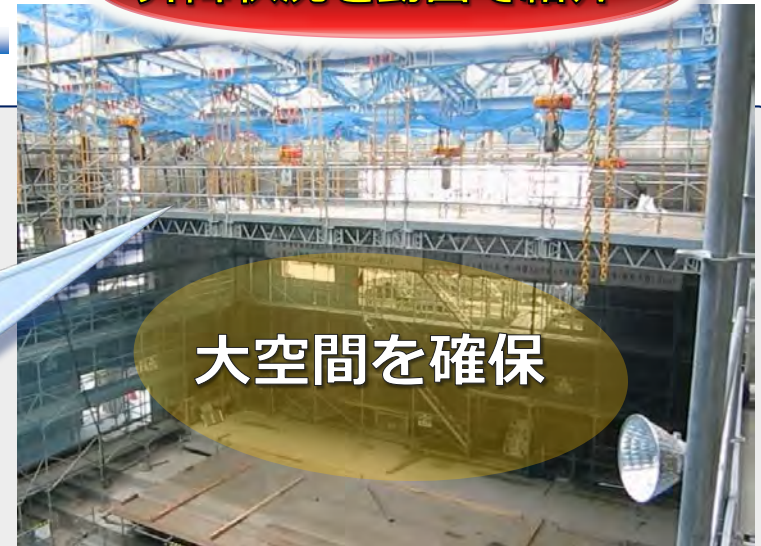
クイックデッキ吊り上げ
