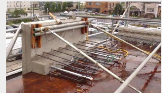
パラペットPCa設置
