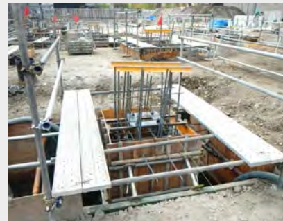
⑤鉄骨用アンカー設置
