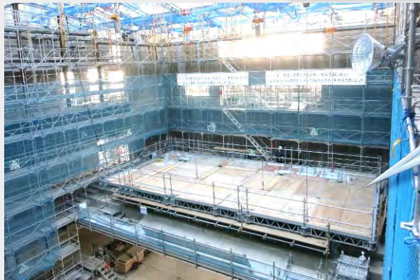
クイックデッキ吊り上げ前
