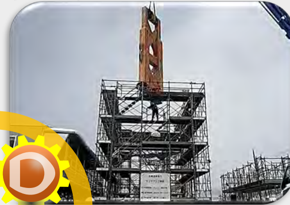
チームでモックアップ施工
