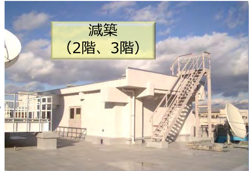
塔屋 復旧完了 （減築にて対応）
