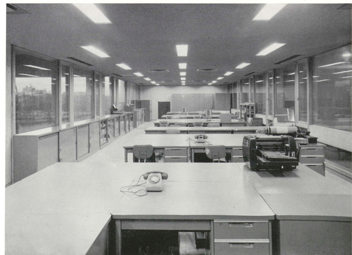
■ 中2階事務室 Mezzanine office-room
