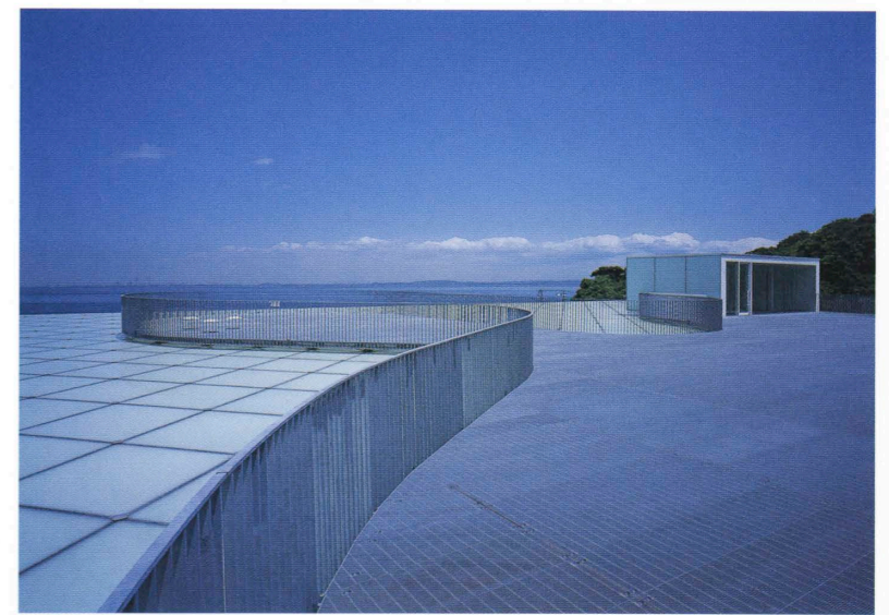
屋上広場 Roof terrace.
