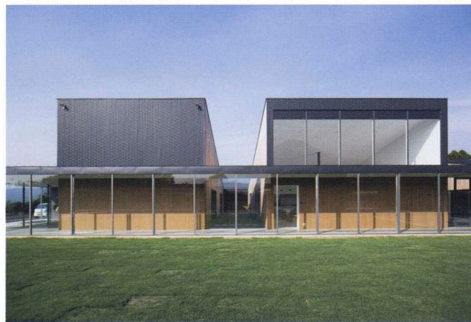
ラウンジ棟とエントランス棟 Lounge and entrance buildings.
