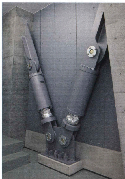
制振ダンパー Damper.
