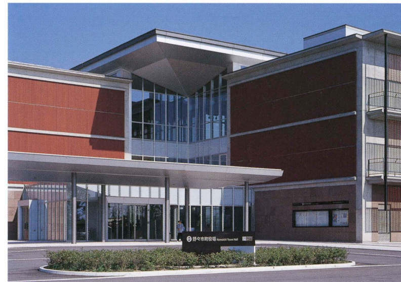
西側アプローチ West side approach.
