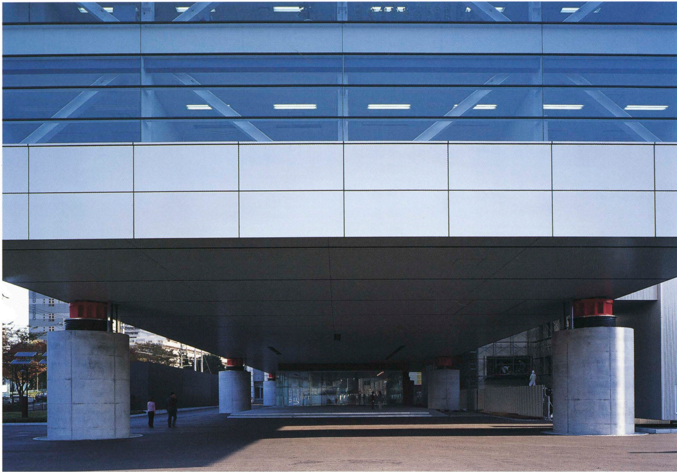
北側よりピロティを見る View of the pilotis from the north.
