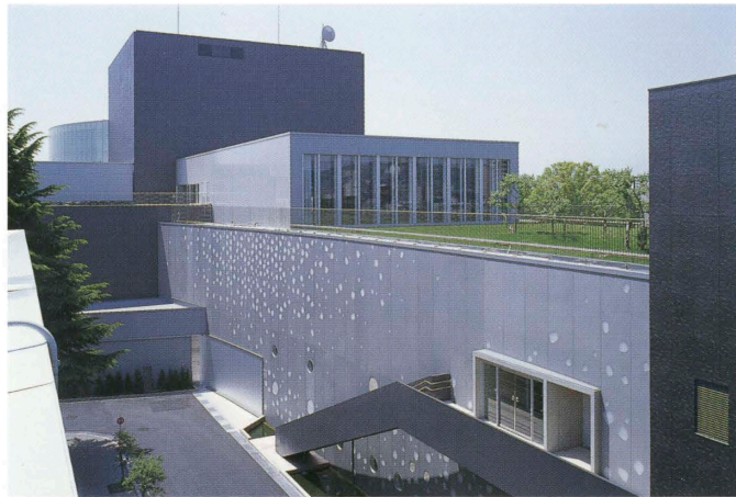
東側から屋上トップガーデンを見る Top garden on the roof view from east.
