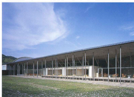
西側から見る View from the west.
